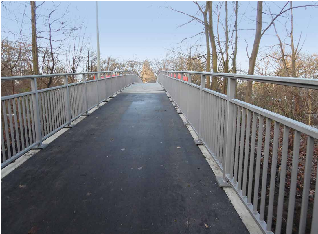
Die sanierte Rad-/Fußwegbrücke über die Münchener Straße ist seit Ende Dezember 2015 wieder passierbar.
