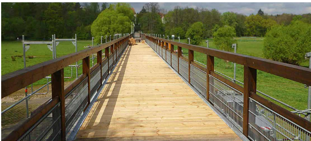
Der 260 Meter lange Steg im Pegnitztal erhielt einen neuen Belag und ein neues Geländer.
