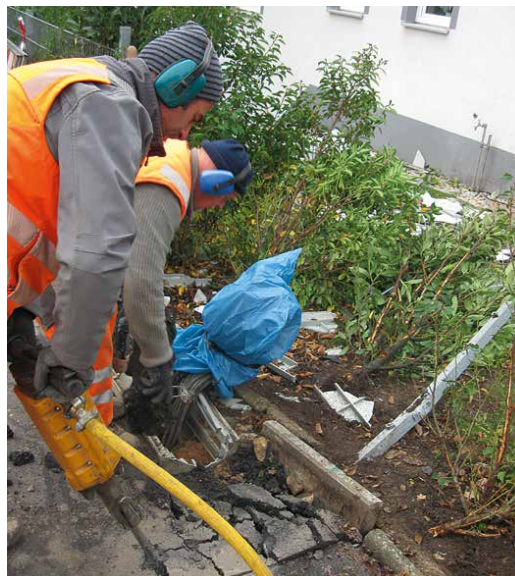
Nach dem Unfall sichert der Bereitschaftsdienst von SÖR zuerst die Unfallstelle. Bevor das neue Steuergerät aufgebaut werden kann, muss erst der zerstörte Sockel des Schaltkastens entfernt werden.
