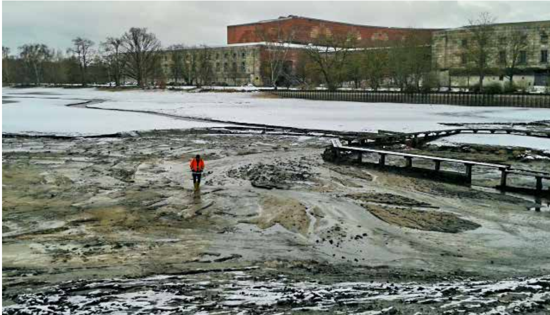
Im Winter 2015/2016 blieb der Große Dutzendteich leer. Nur so können umfangreiche Unterhaltsarbeiten durchgeführt werden.
