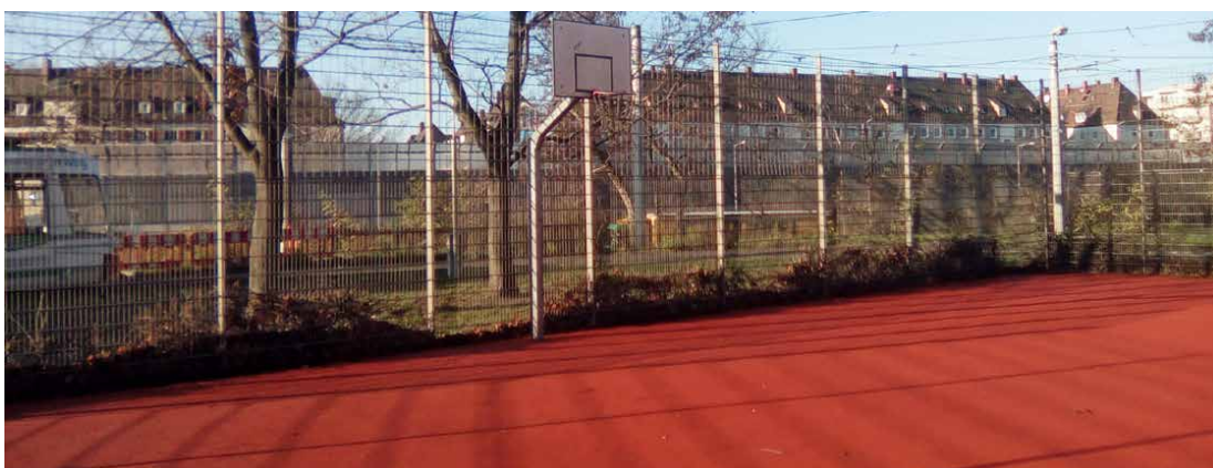
Wegen einer VAG-Baustelle an der Wendeschleife Dianaplatz musste der Bolzplatz dort weichen. Schnell errichtete SÖR einen Ersatzbolzplatz in der Nimrodstraße. Nach der VAG-Baumaßnahme stellte SÖR einen neuen Bolzplatz an altbekanntter Stelle wieder her.
