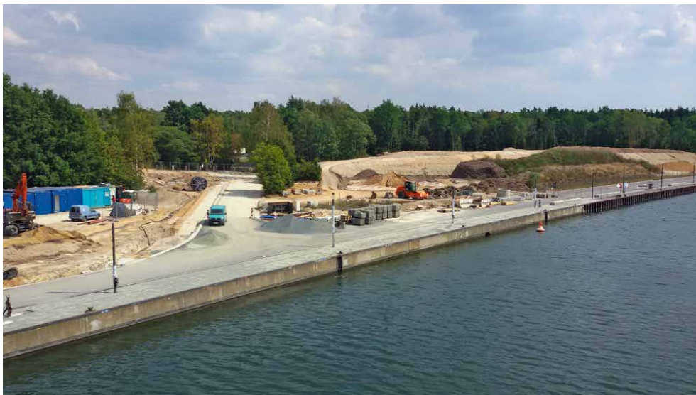
Auf 1,4 Kilometer entlang des Main-Donau-Kanals schuf SÖR zehn Liegeplätze für die Personenschiffahrt. Hier können die Schiffe sich mit Frischwasser und ab März 2016 auch mit Strom versorgen. Zudem wurde die Zufahrt für Reisebusse verbessert. Im Frühjahr 2016 wird das Projekt abgeschlossen.
