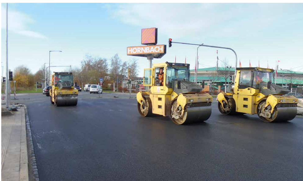
Kurz vor Abschluss der Arbeiten im November 2015 ebnen Planierraupen den Weg.
