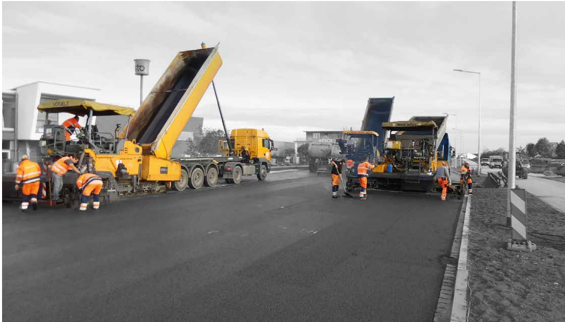
SÖR/1-S koordiniert und plant den Umbau und die Sanierung von Straßen, Wegen und Plätzen in Nürnberg. Hier sind es Bauarbeiten an der Höfener Spange.
