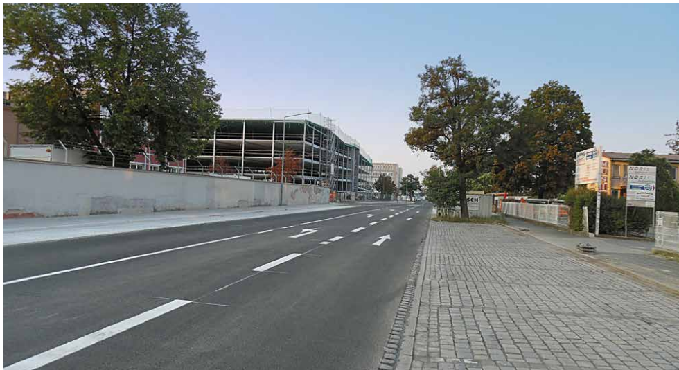
Eine Links- und Rechtsabbiegerspur für das neue Parkhaus auf dem MAN-Werksgelände, mehr Parkplätze durch Längsparkstreifen, ein neuer Vorplatz für die Diskothek "Hirsch", Verlegung der Haltestellen und fünf neue Bäume – das Ergebnis der Umbauarbeiten in der Vogelweiherstraße.
