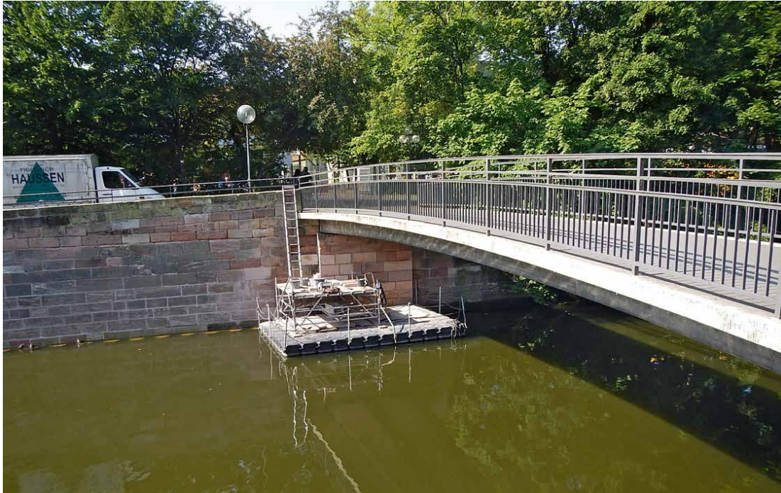
Die Ufermauern der Pegnitz werden vom Floß aus saniert, dabei muss die Optik immer zum historischen Bild der Altstadt passen. In den letzten Jahren arbeitete SÖR verstärkt an der Sanierung.
