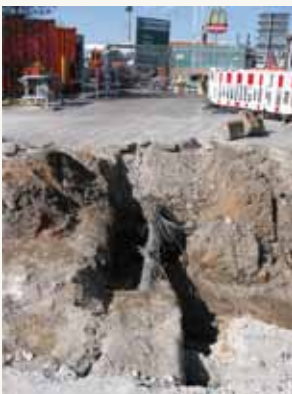
Um Platz für die Arbeiten des Brückenbaus und des Straßenbaus zu schaffen, wurde die unterirdische Verkabelung der stationären Lichtsignalanlage geborgen.
