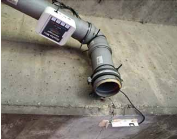
Messung der Rissbreiten unter dynamischer Belastung (Monitoring)
