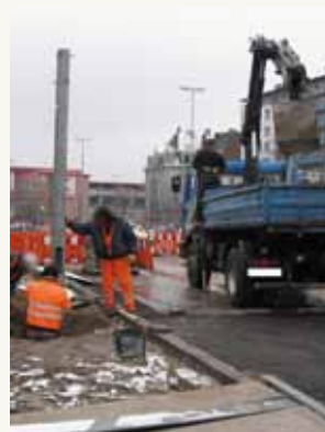
Die Masten und die Verkabelung der stationären Anlage wurden, sobald es der Baufortschritt der Hauptmaßnahme zuließ, Baufeld für Baufeld errichtet.
