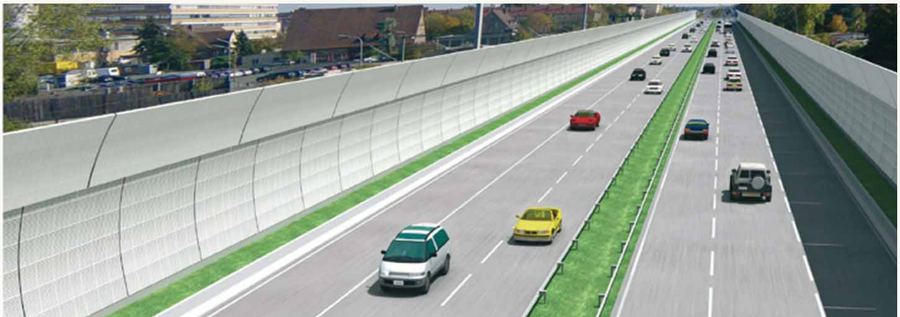
Als Folgemaßnahme werden beidseitig ca. 8 m hohe Lärmschutzwände im Bereich der Wohnbebauung errichtet
