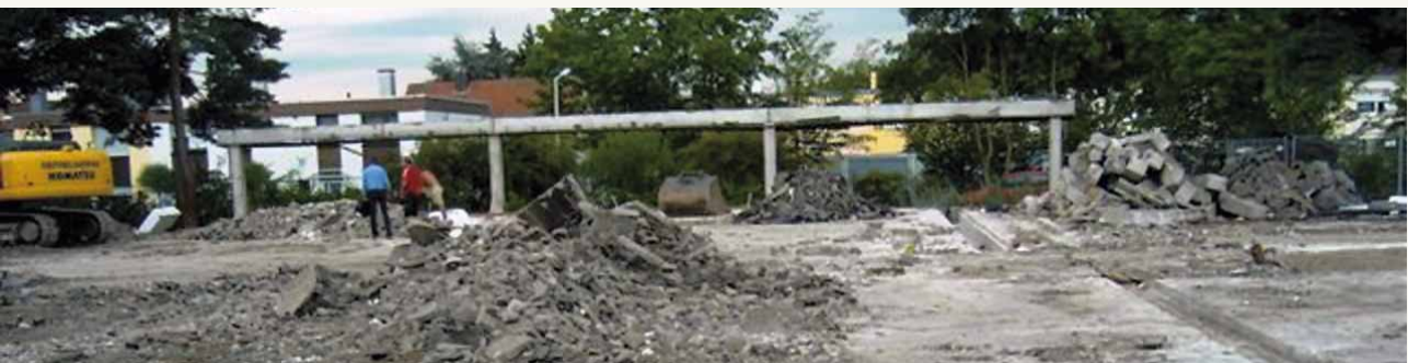
... und während des Rückbaus
