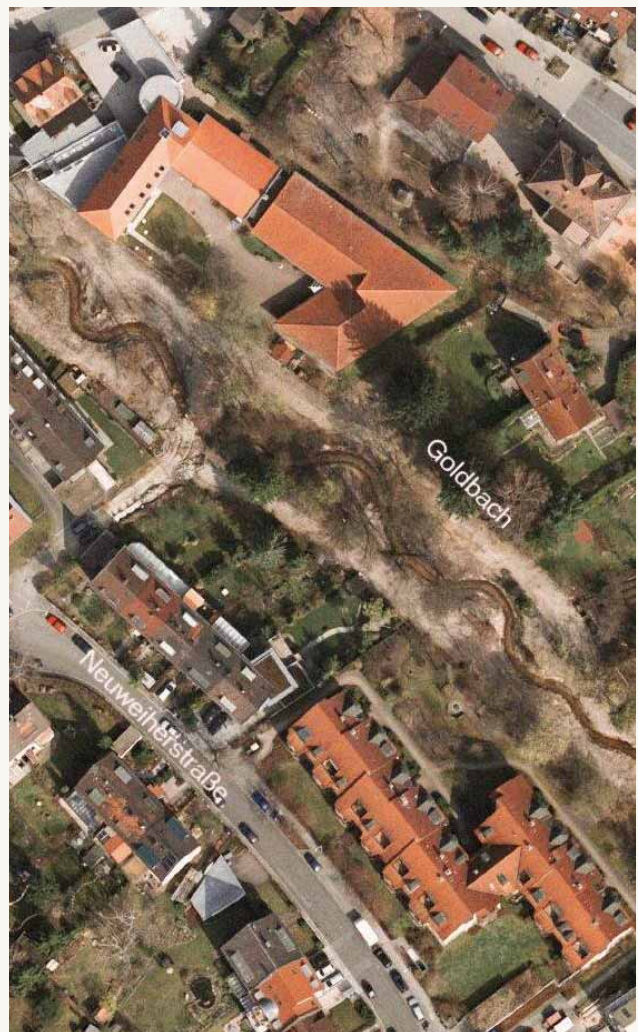
Bachgestalt nach dem Erdbau
