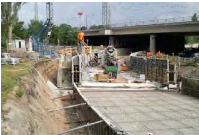
Bauarbeiten am Trog.
