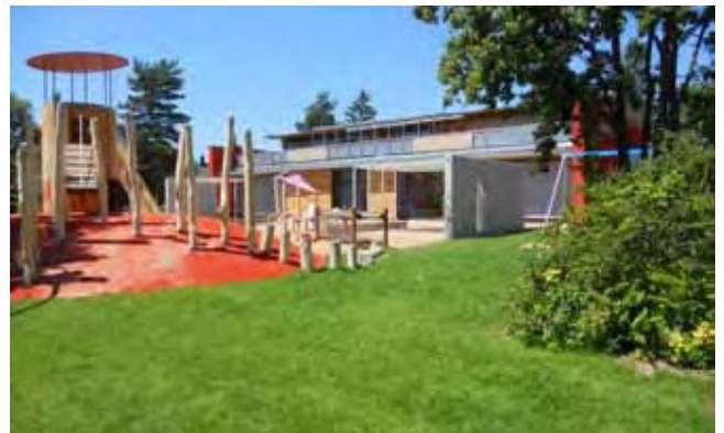
An der Schnittstelle von Gebäude und Freiraum liegen Terrassen. Schwerpunkt des Spielangebotes ist hier ein Spielhügel mit Klettergeräten und Rutsche sowie eine Schaukel.
