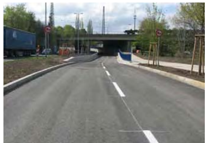
Fertiggestellte abgesenkte Fahrbahn.
