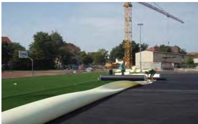
Der Kunstrasenplatz im Bau.
