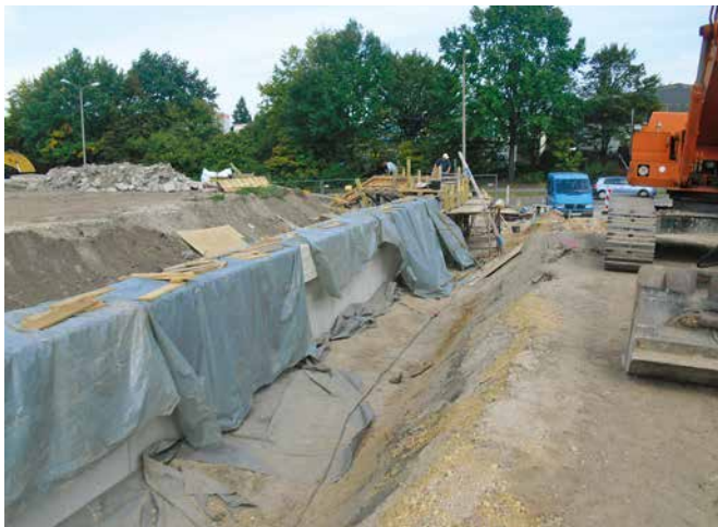
Herstellung einer Stützwand und Wegebau in der Antalyastraße
