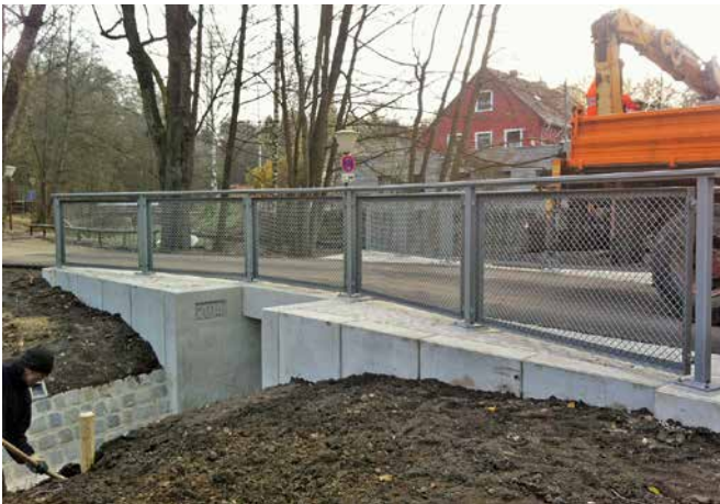
Neues Bauwerk 2014 nach der Fertigstellung
