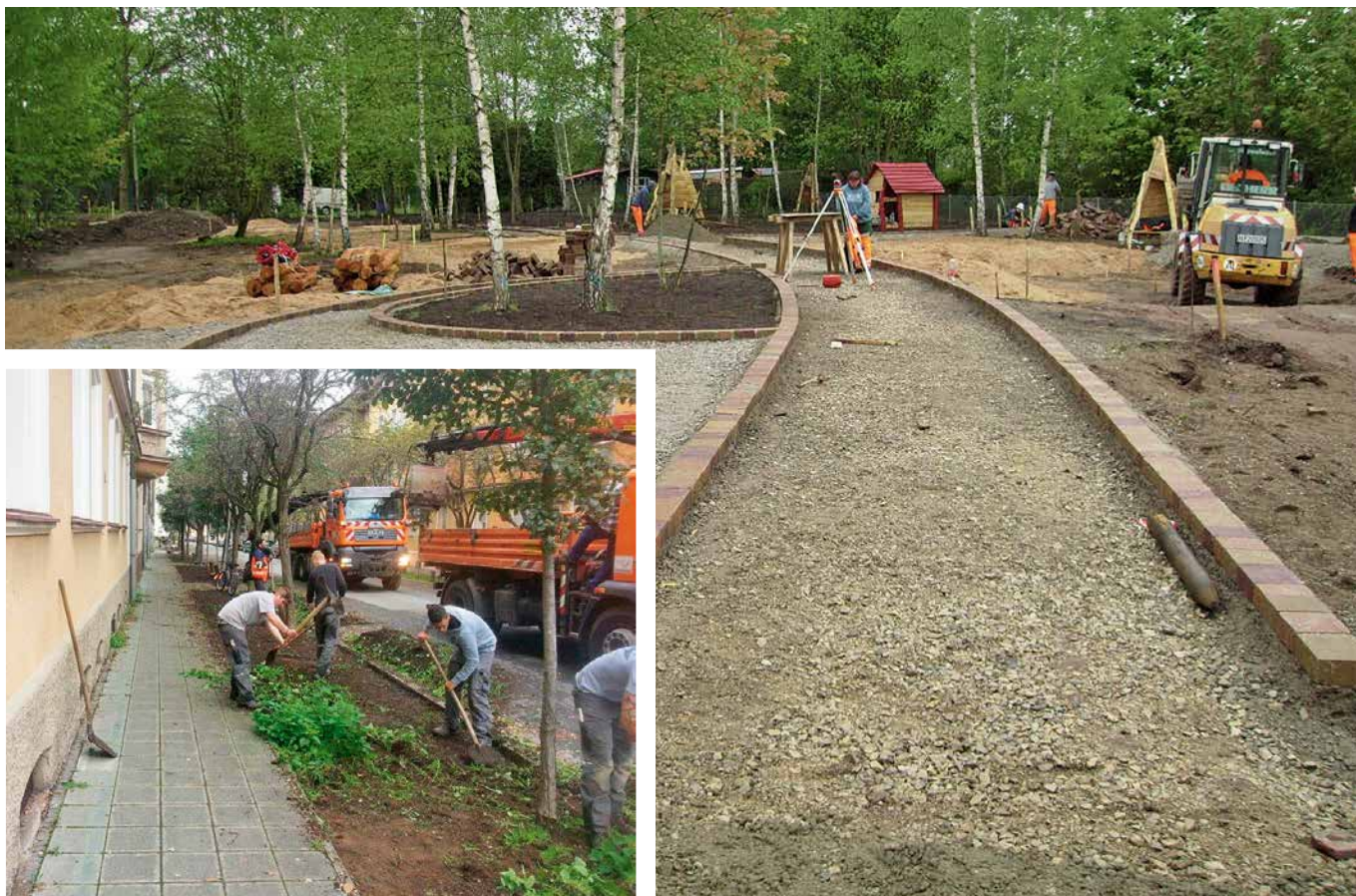
Südstadtaktion 2014 – Straßen, Straßenbegleitgrün, Bäume und Baumscheiben werden saniert
