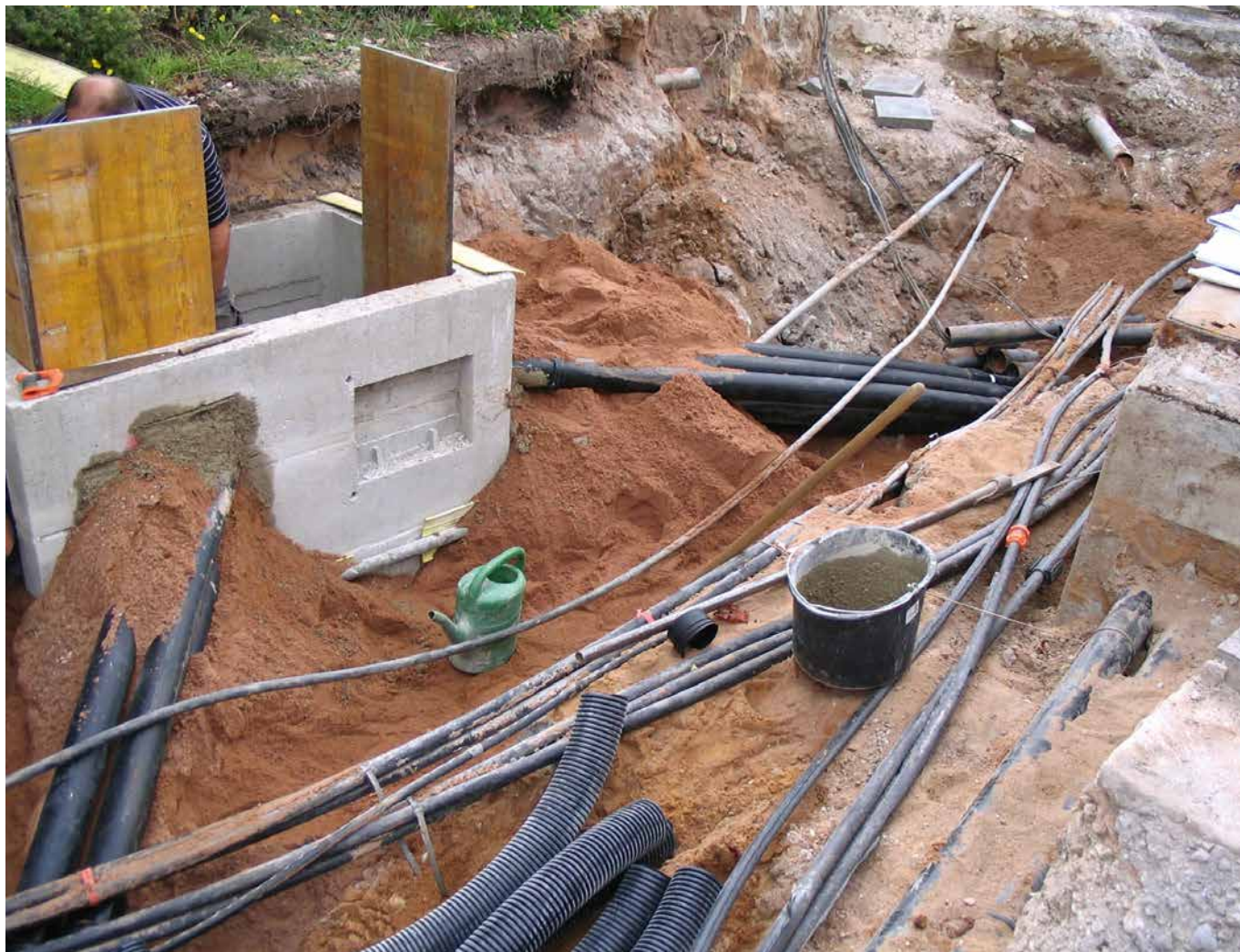
Kabelnetz Projekt Thon – Am Wegfeld
