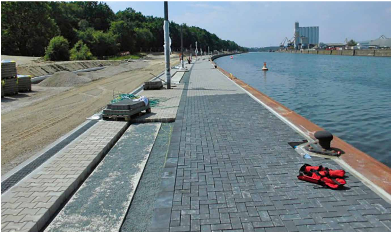
Die ersten Anlegestellen sind nahezu fertiggestellt
