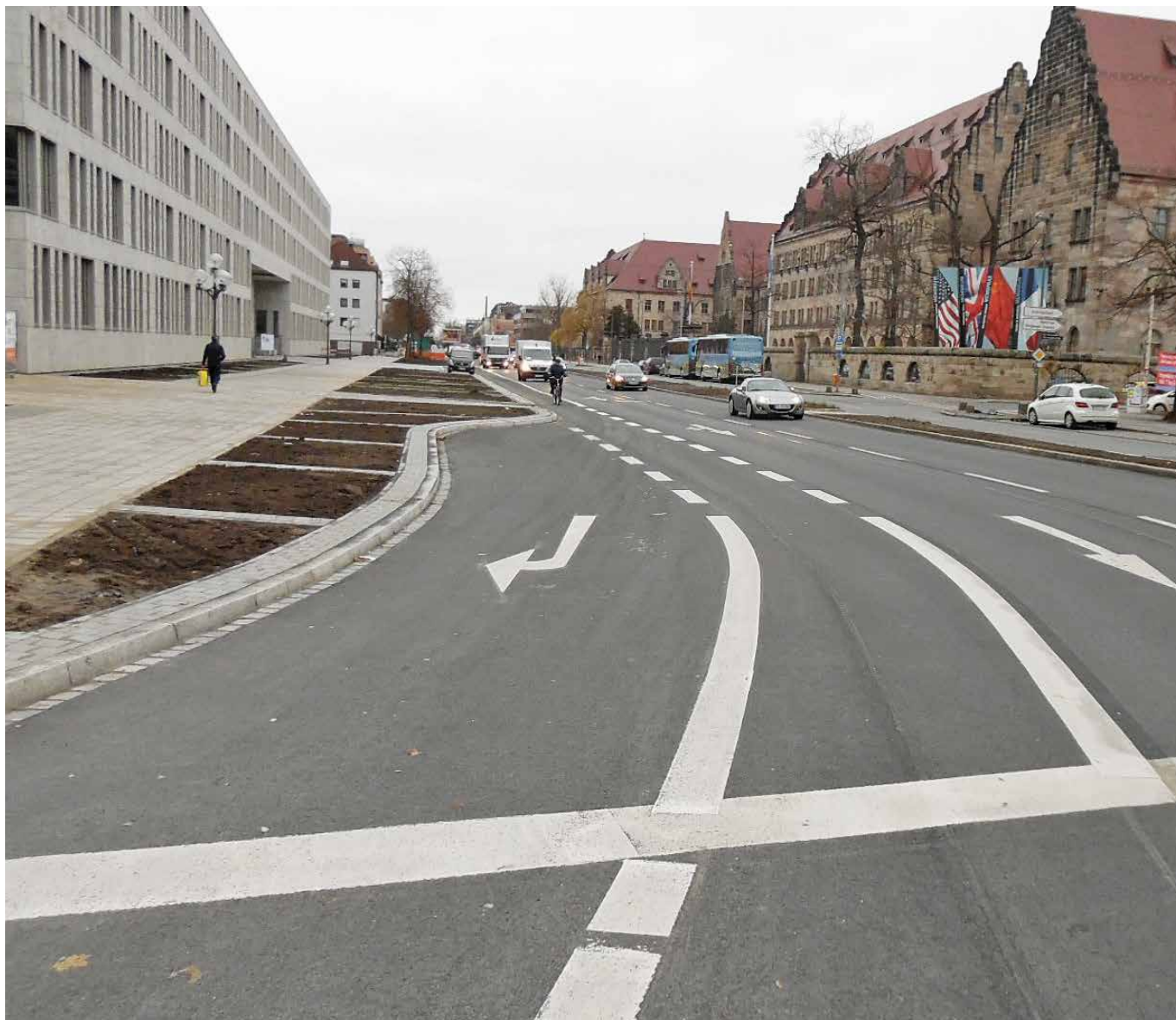
Der Straßenbau in der Fürther Straße ist fertiggestellt
