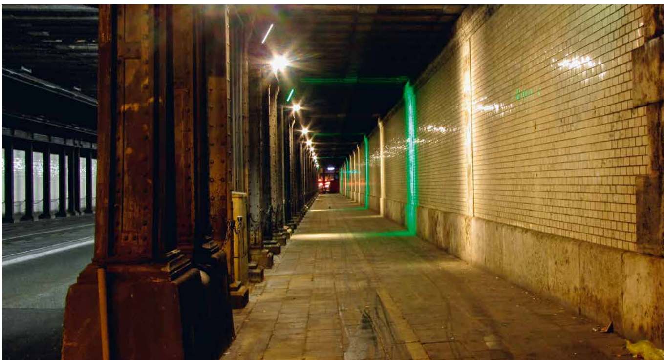
Die Allersberger Unterführung vorher und nachher mit dem neuen Beleuchtungskonzept
