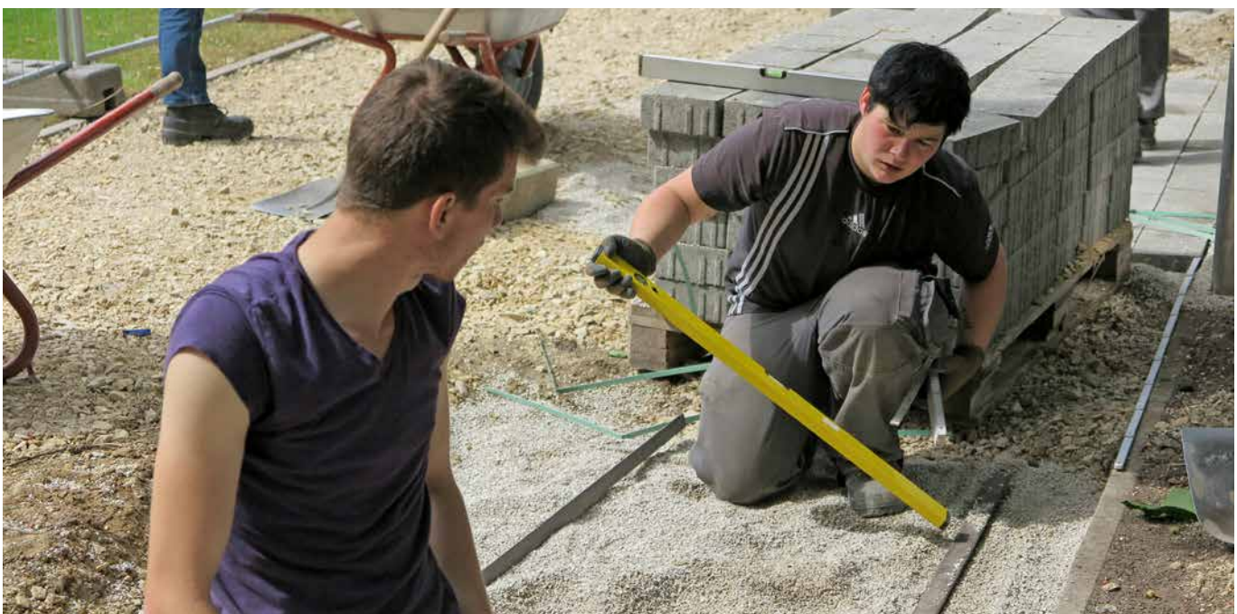
David Häcker und Magdalena Schön - beide in der Ausbildung - verlegen Pflastersteine
