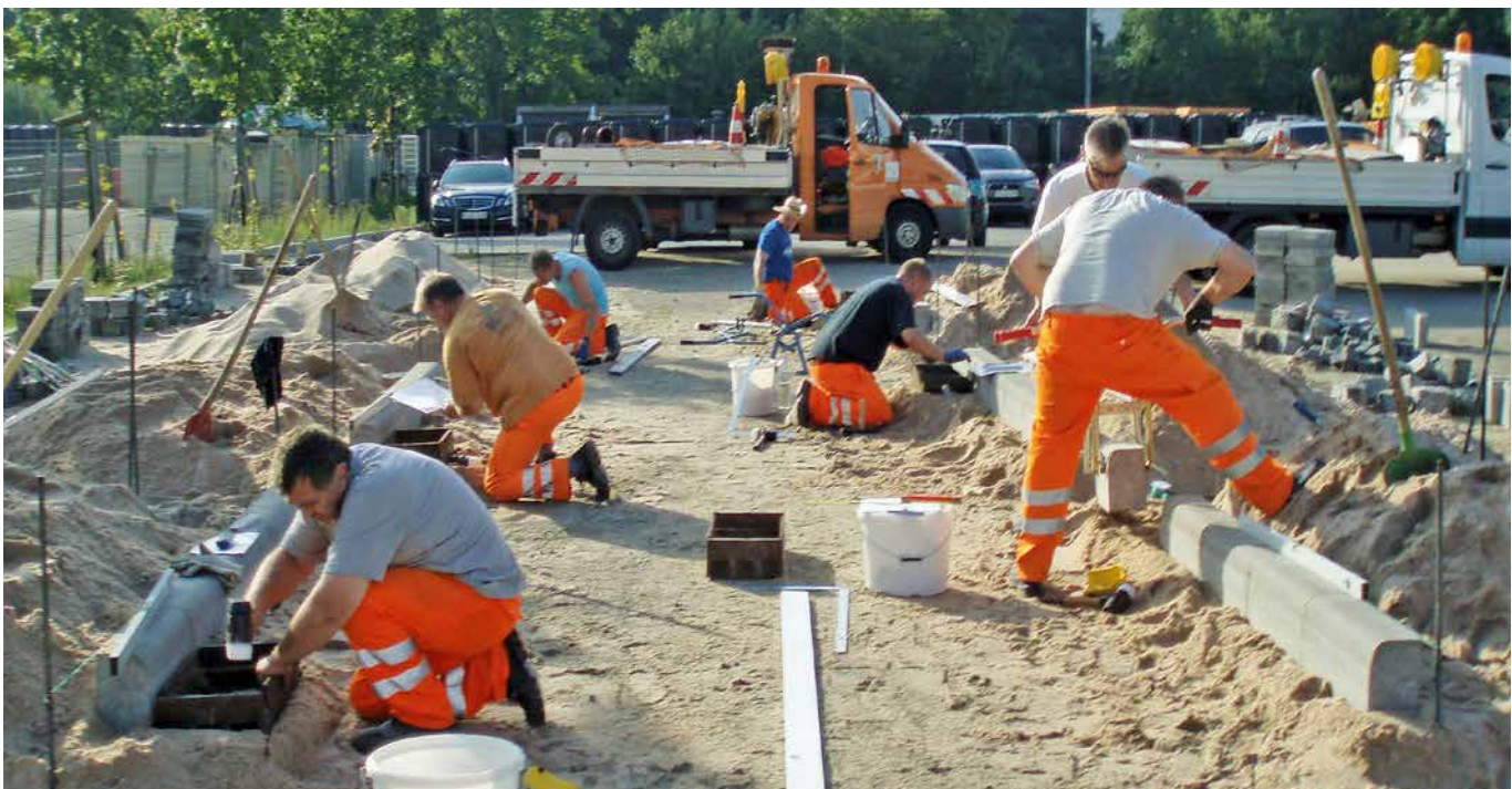
Mitarbeiter am Prüfungstag beim Setzen von Betonrandsteinen
