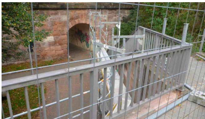
Sanierung Sandsteinmauer und Treppenanlage
