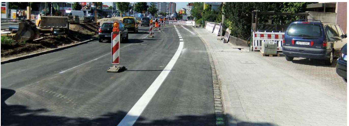
Äußere Bayreuther Straße vor Asphalteinbau und Schaffung des Radfahrstreifens
