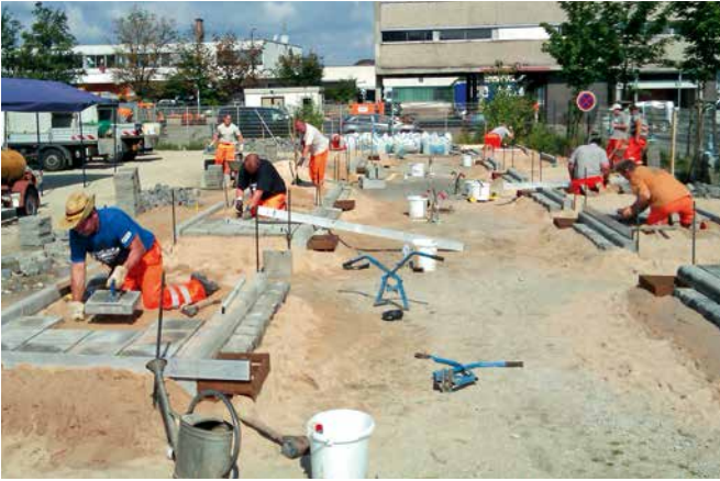
Die Randeinfassungen sitzen, jetzt wird der Plattenbelag verlegt
