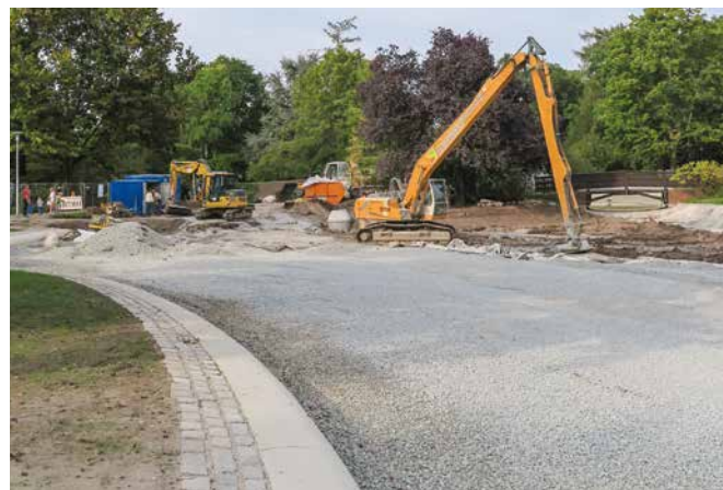
September: Das Ende der Baustelle ist in Sicht
