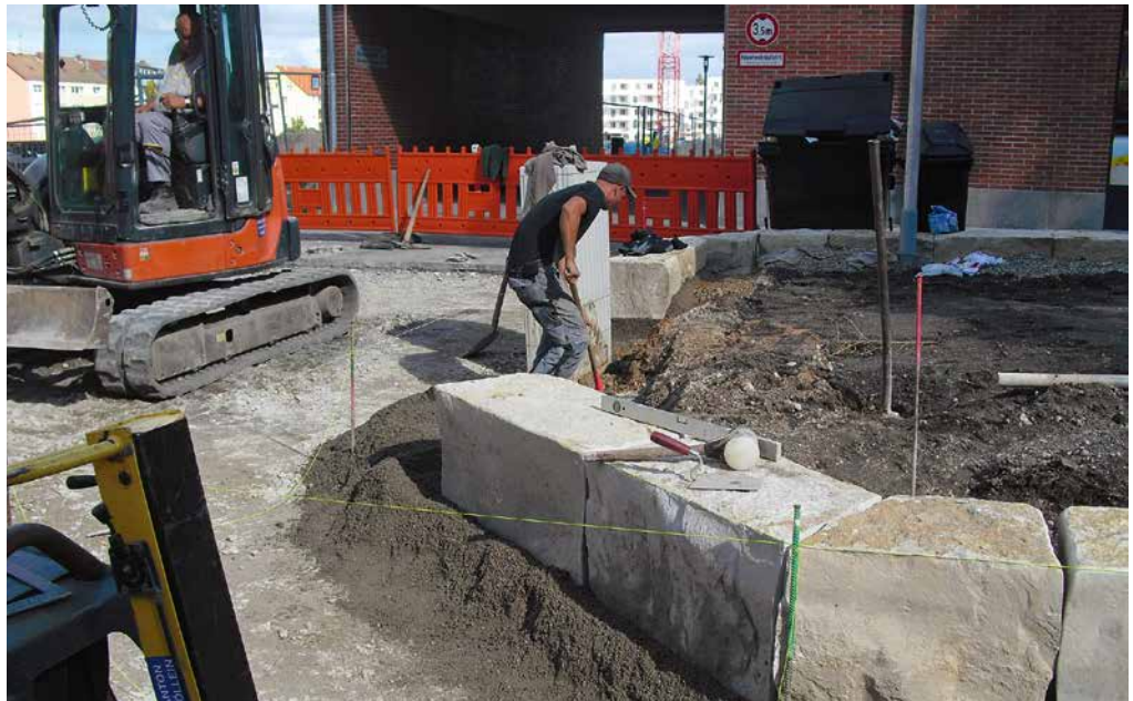
Straßenbauarbeiten am Schillerpark
