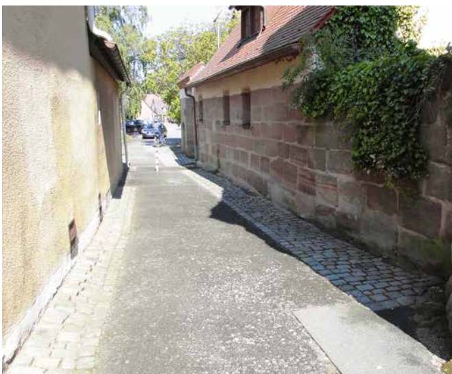
Der Kirchenvorplatz vor und nach der Neugestaltung. Der marode Asphalt wurde durch Granitgroßpflaster ersetzt
