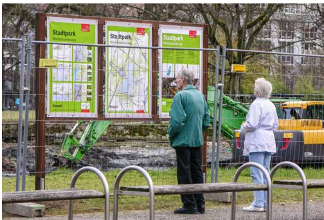
Bürgerinnen und Bürger verfolgen mit Interesse den Verlauf der Baustelle
