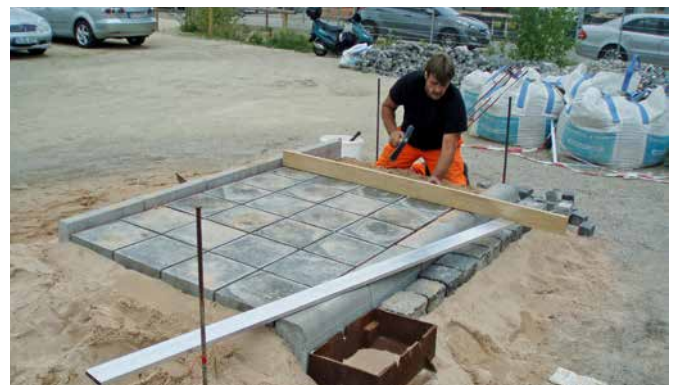
Das Werkstück vor der Vollendung. Nun muss nur noch das Granitkleinstpflaster verlegt werden
