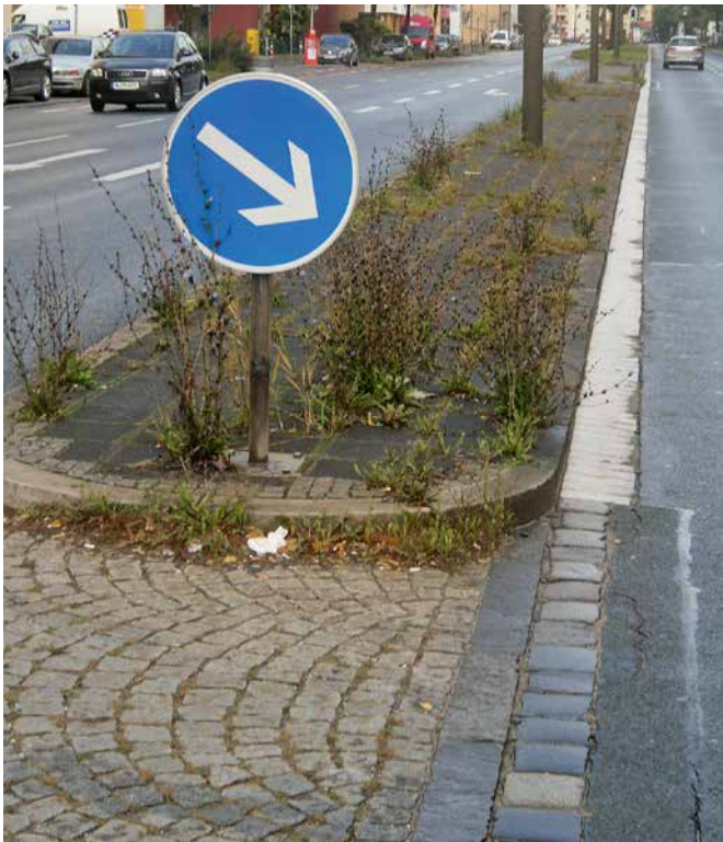
Welser Straße - Verwahrloster Anblick vor der Sanierung
