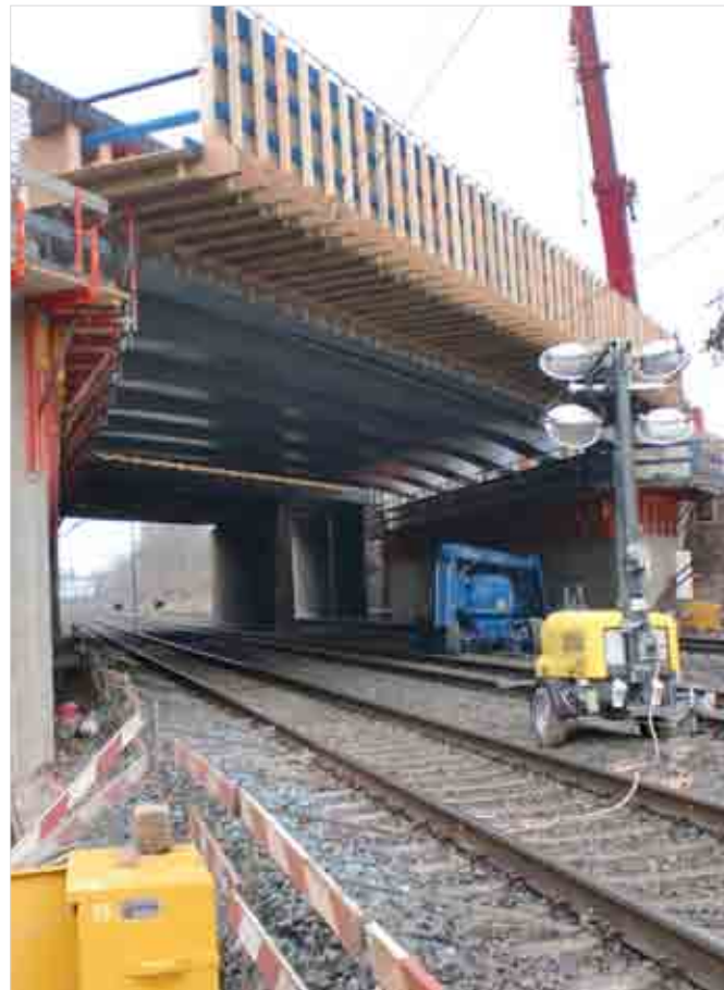
Mit Fertigteilträgern: Die Lücke ist überbrückt
