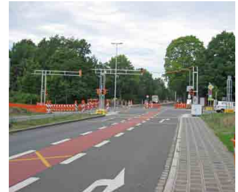
Ein anderes Beispiel: Baustellen-Absperungen und mobile LSA während des Umbaus der Marienbergstraße
