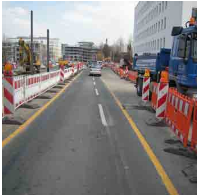
Bahnhofstraße Blickrichtung Wöhrder Talübergang – Umbau
