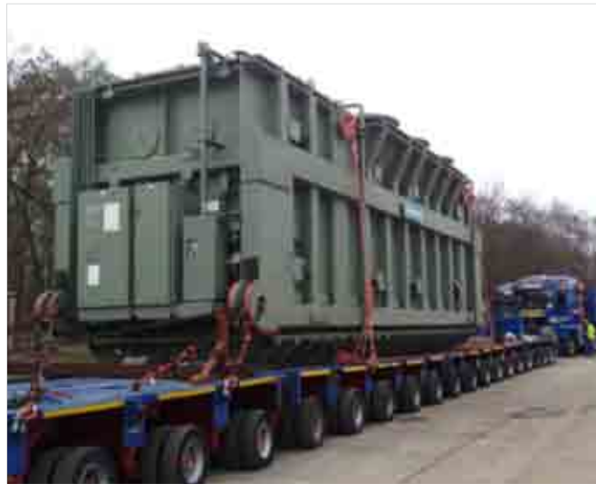
500 Tonnen Schwertransport Siemens-Trafo vom Hafenge- lände in der Nacht vom 06. März 2013 auf den 07. März 2013
