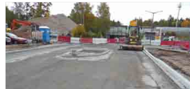
Baustelle Fußgängerinsel Löwenberger Straße
