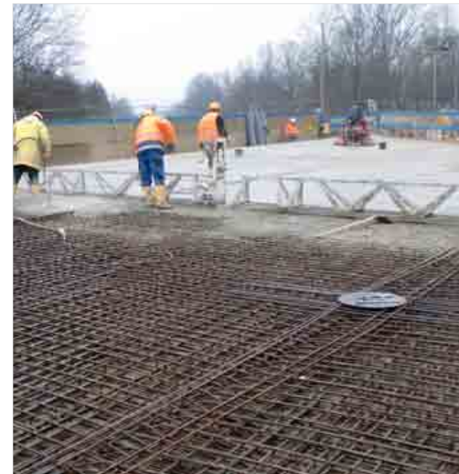
Trotz Großbaustelle floss der Straßenverkehr zweispurig und der Bahnverkehr blieb aufrecht.
