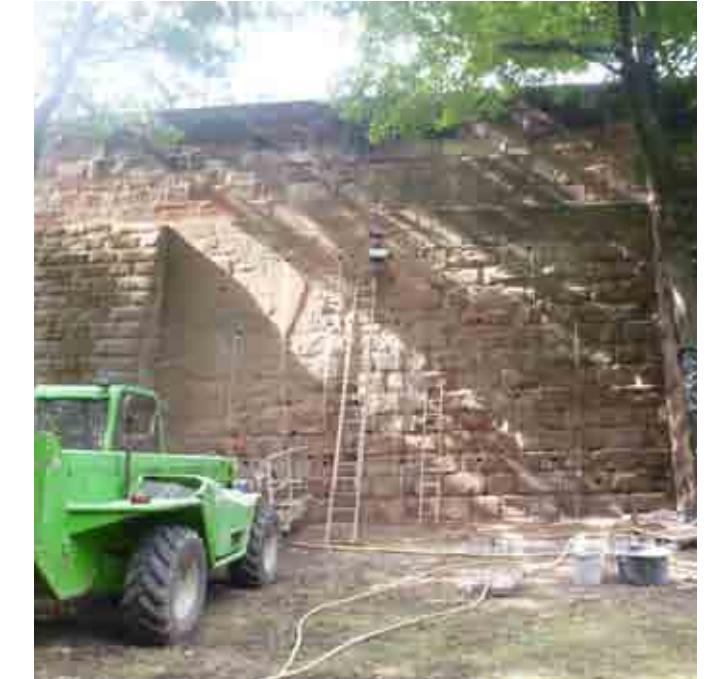
Danach werden die zur Rückverankerung nötigen Bohrlöcher verpresst
