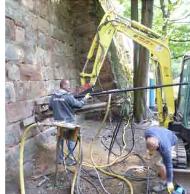
So werden die Nägel angebracht, um die Stadtmauer zu stabilisieren
