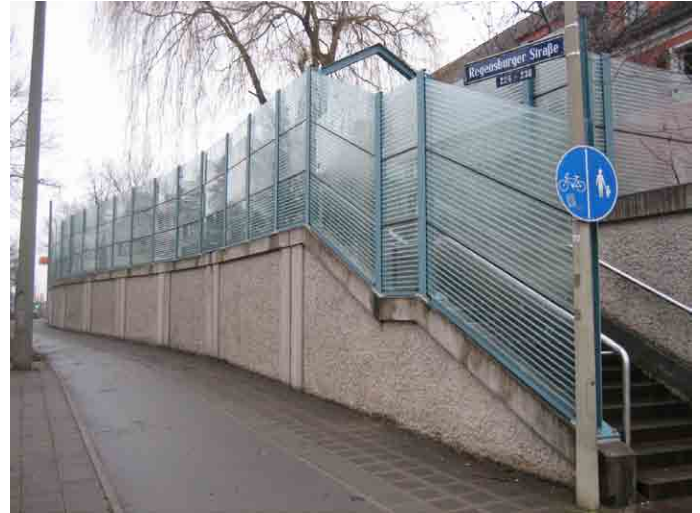
Lärmschutzwand Regensburger Straße
