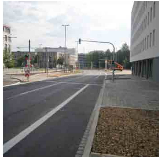
Bahnhofstraße Blickrichtung Wöhrder Talübergang – fertiggestellt
