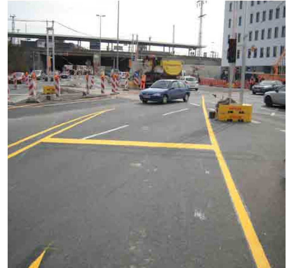
Baustellenabsperungen und mobile LSA während des Umbaus
