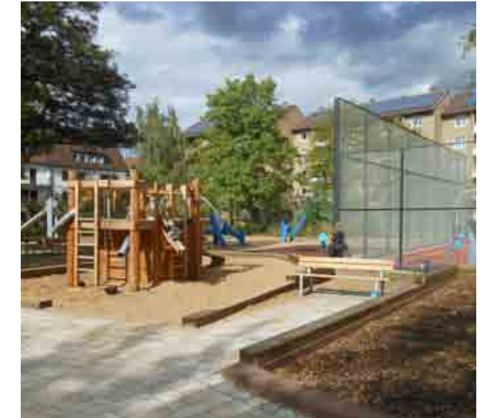
Spielplatz nach Fertigstellung
