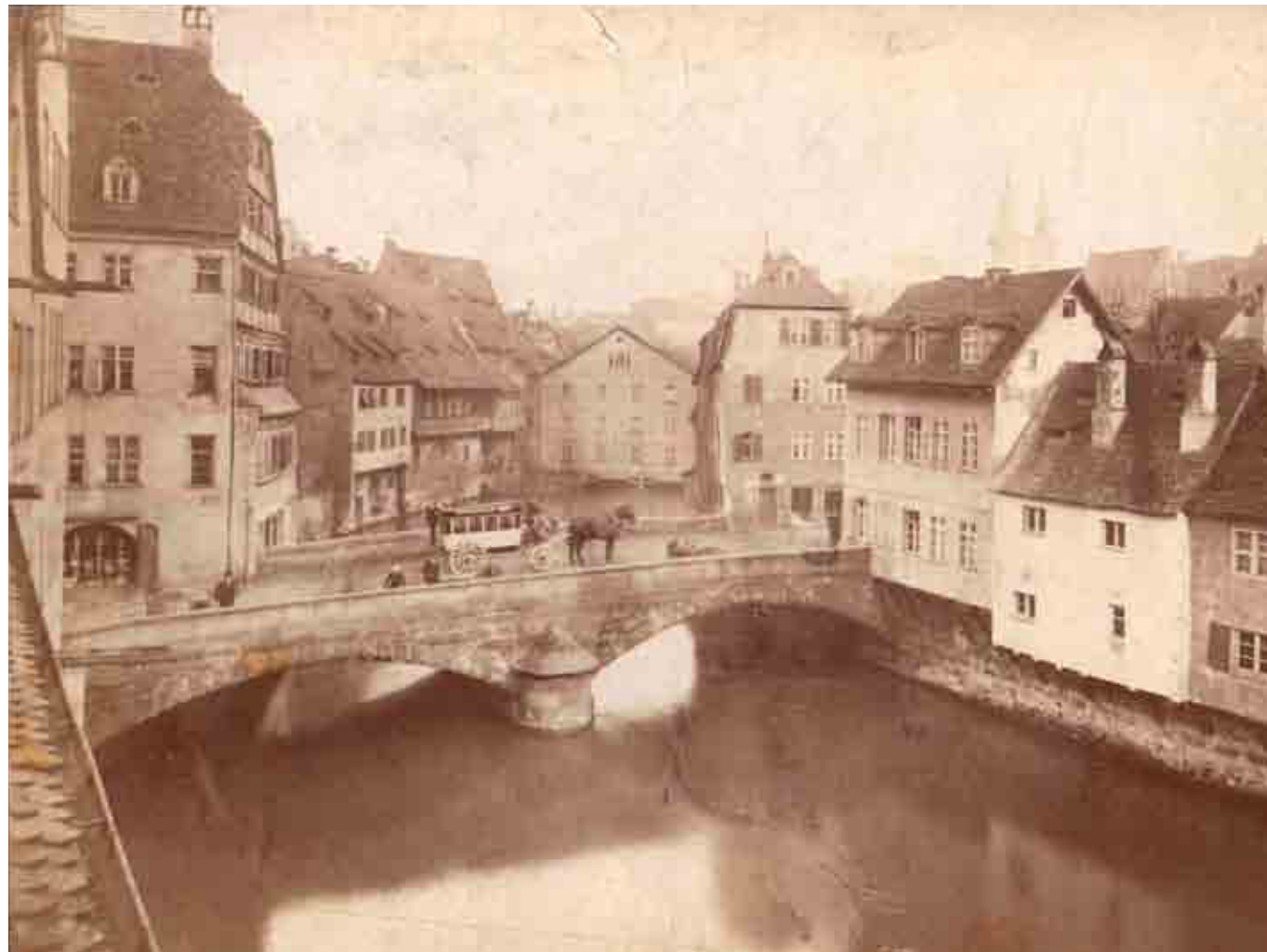
Historische Bebauung und die Brücke vor über 100 Jahren. Teile der benachbarten Häuser wurden auf die Brücke gebaut.
