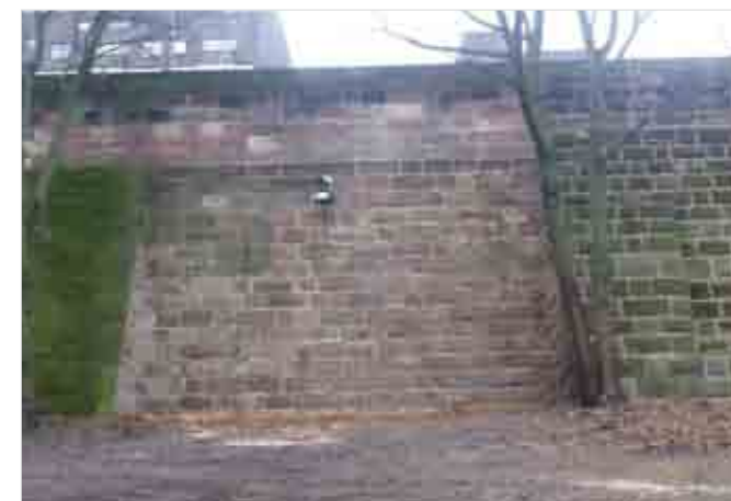
Die Stadtmauer nach der Sanierung und Instandsetzung
