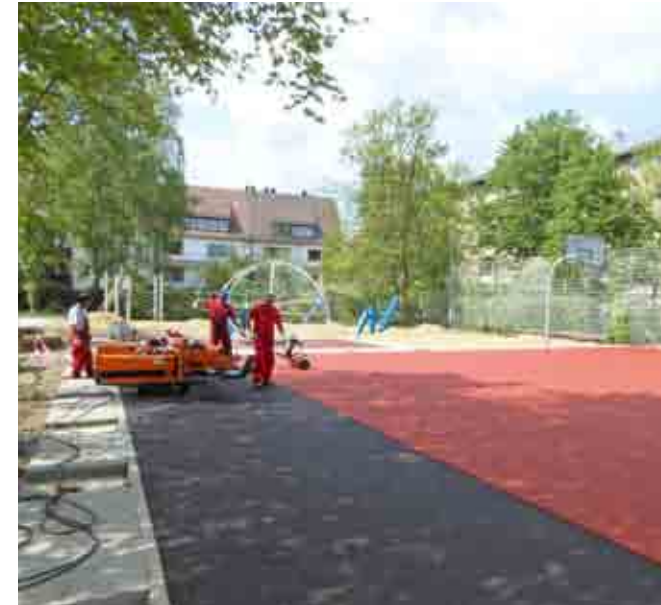
Kunststoff-Belag Ballspielfeld im Bau
