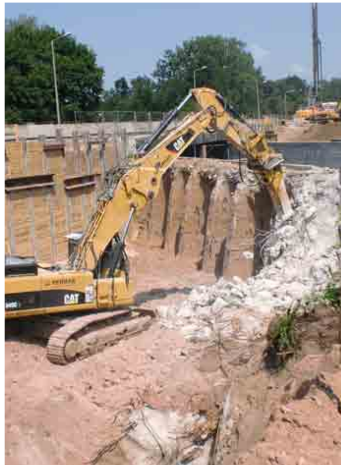
Platz für die neue Brücke: Abbrucharbeiten im Juni 2013
