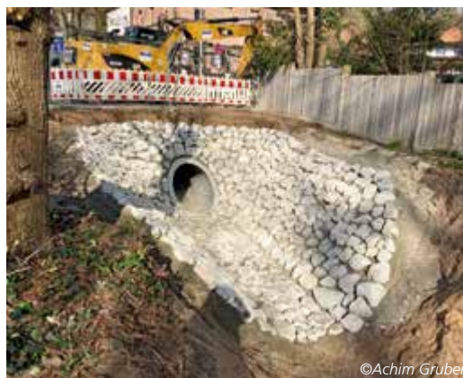
Klingengraben: Neuverlegung der Rohre (links), neuer Auslauf (rechts).
