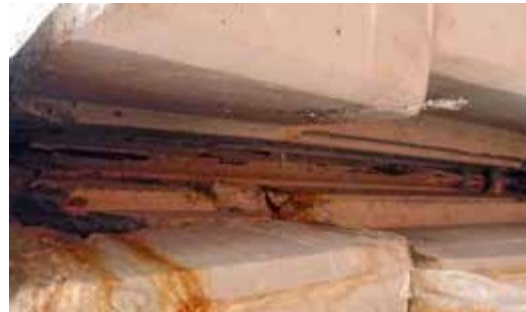
5. Freilegen der Bewehrung mit Höchstdruckwasserstrahlen („HDW-Verfahren“).
