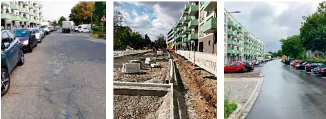
Nach der Sanierung weist die Fahrbahn der Elbinger Straße keine Risse mehr auf, dafür neue Parkbuchten.
