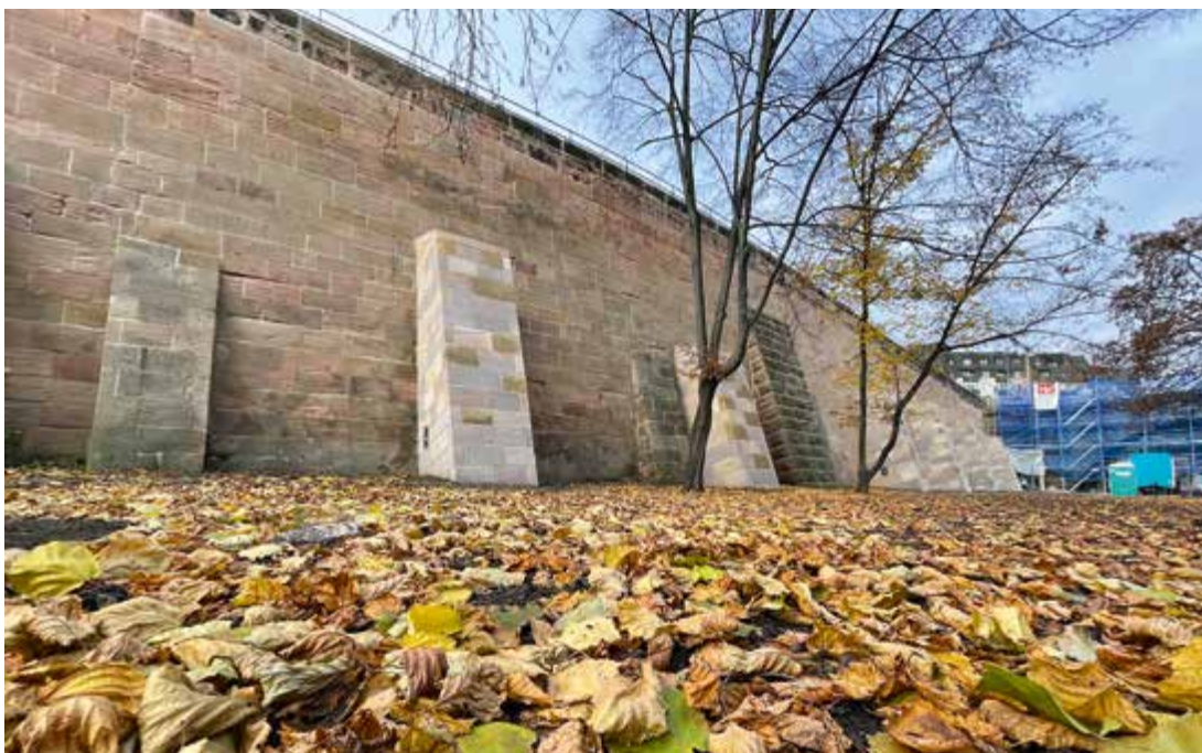
Auch Stützbauwerke wie die Stadtmauer gehören zum Aufgabenbereich von SÖR/1-B.
