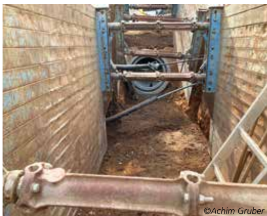
Klingengraben: Neuverlegung der Rohre (links), neuer Auslauf (rechts).
