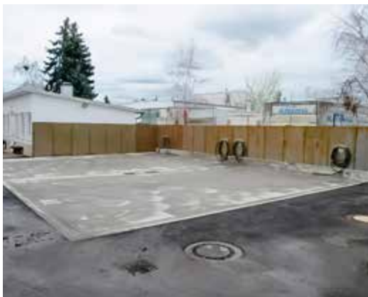
Abgeschlossen wurden auch die Arbeiten zur Errichtung eines Waschplatzes für Kleinkehrmaschinen am Standort Hans-Bunte-Straße 22.
