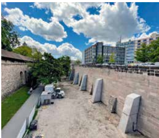
Die Arbeiten am Fürther Tor.
