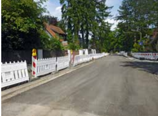
Erneuerung der Fahrbahndecke auf einem Abschnitt der Wackenroderstraße.
