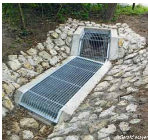
Erneuerter Überlauf am Kothbrunngraben (links), Einlauf mit Gitter am Valznergraben (rechts).
