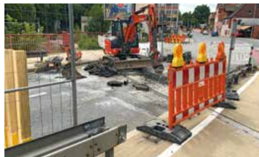
6. Einheben der neuen Konstruktion.
