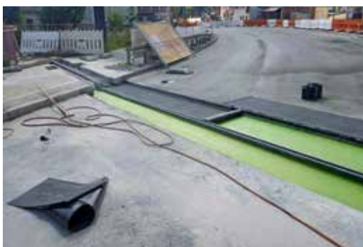
4. Ausbau der alten Konstruktion.
