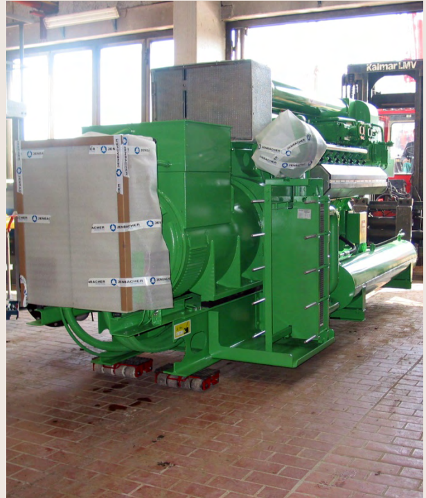
Ein Gasmotor der BHKW-Anlagen während der Montage.
