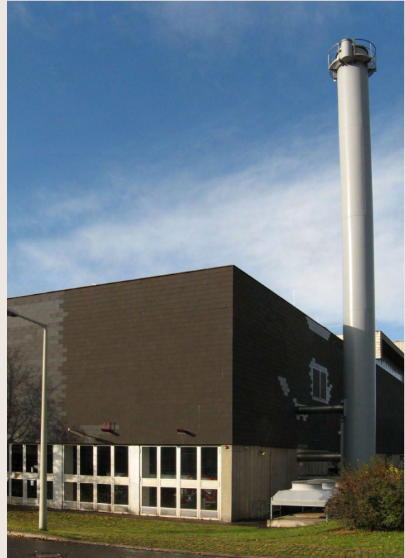
In diesem Gebäude sind die Blockheizkraftwerke untergebracht. Rechts einer der beiden Abgaskamine und die Notkühlung der ersten Anlage von 2003.
