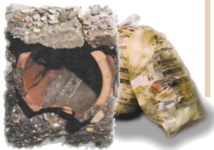
Stein, Niederehe, Instandhaltung von Kanalisationen
