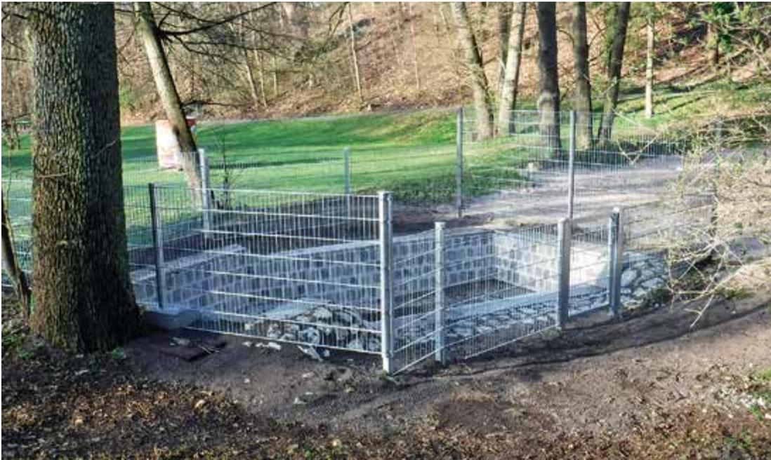
**Der Hochwassereinlauf am Tiefgraben war sanierungsbedürftig.** Die Böschungssicherungen und das Gelände aus Holz waren morsch und teils nicht mehr vorhanden.
