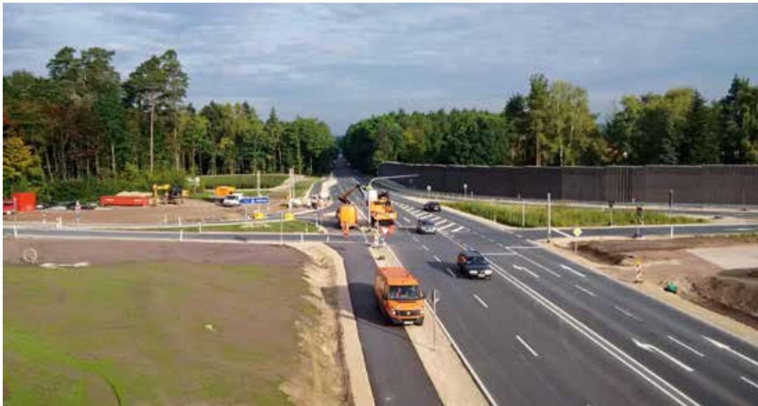
Im Zuge des 6-streifigen Ausbaus der Autobahn A6 hat SÖR/1-E/2 an beiden Rampen der Autobahnausfahrt Langwasser auf Höhe der Gleiwitzer Straße neue Lichtsignalanlagen errichtet.
