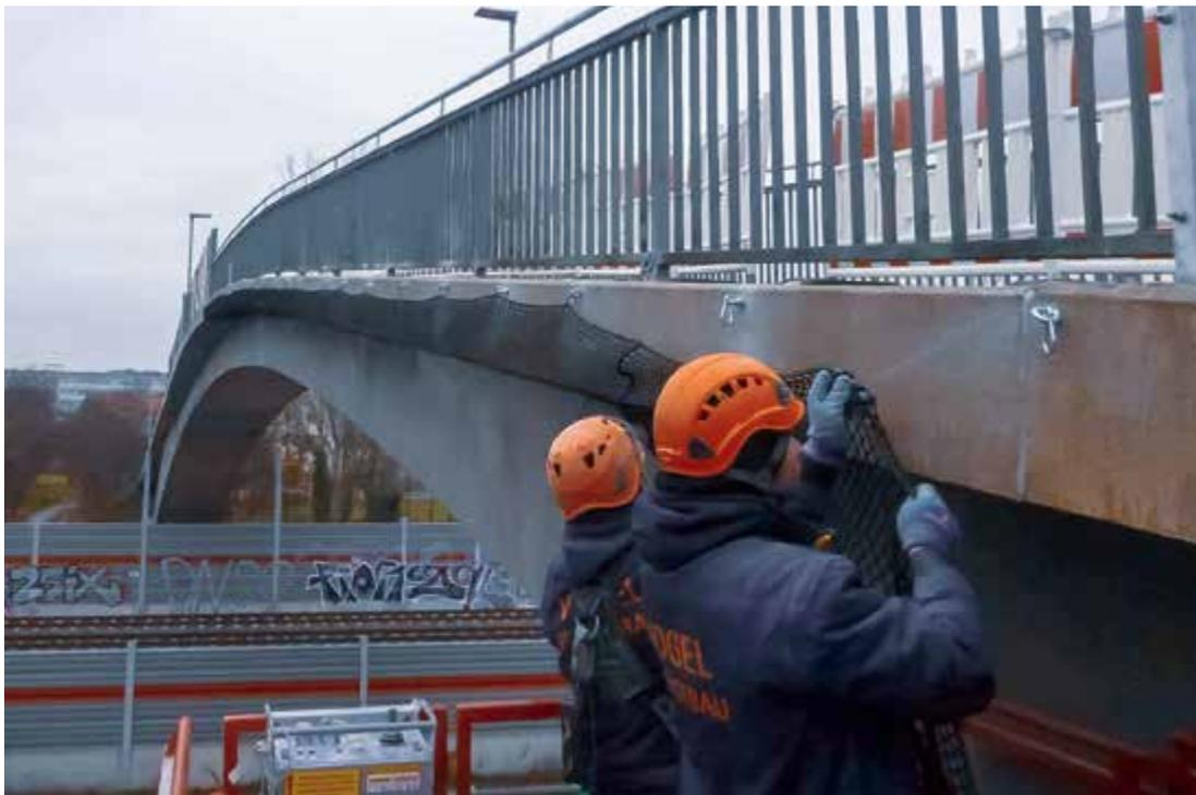
**Am unteren Rand der Brücke (Gesims) wurde ein Netz angebracht, weil aufgrund des Alters und Verschleißes nicht ausgeschlossen werden kann, dass sich kleine Betonbrocken lösen können. Das Netz verhindert, dass die Teile auf die darunterliegende Straße oder die Schienen fallen könnten.**
