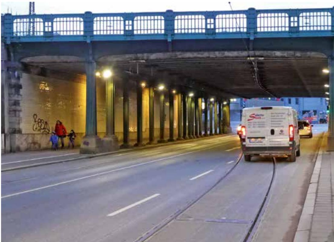
**Die neue Gehwegbeleuchtung wird über einen Sensor je nach Umgebungshelligkeit zu- oder abgeschaltet.** SÖR-Projektleiter Norbert Hirschmann: „Damit sind die Geh- und Radwege auch in der Dämmerung und bei trübem Wetter gut beleuchtet. Das erhöht nicht nur das Sicherheitsgefühl der Passanten, sondern entschärft auch die Unfallgefahr zwischen Fußgängern und Radfahrern.“
