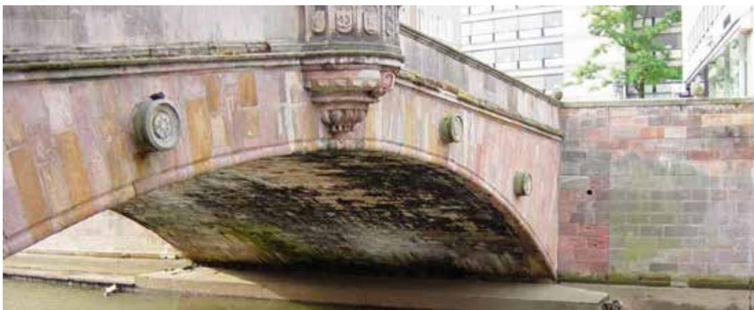
Um die historische Substanz zu sichern und die Stabilität der Brückenkonstruktion zu erhalten, erfolgte eine Sanierung in mehreren Schritten. Im ersten Bauabschnitt 2004 bis 2005 wurde eine konstruktive Abdichtung unterhalb der Fahrbahn ausgeführt.
