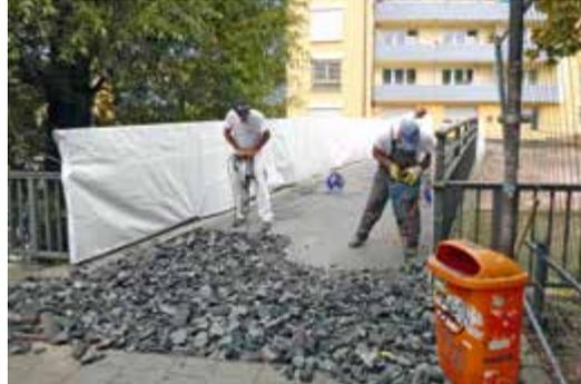
2. Der bituminöse Altbelag wird entfernt.
