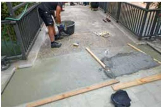
5. Einbau der Ausgleichsschicht auf der Brückentafel (PCC: polymervergüteter zementgebundener Estrichmörtel).
