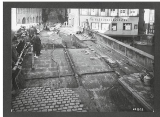
**1928 wird überlegt, die schadhafte Brücke abzureißen; man sieht die knapp unter der Oberfläche verlegten Versorgungsleitungen.**
