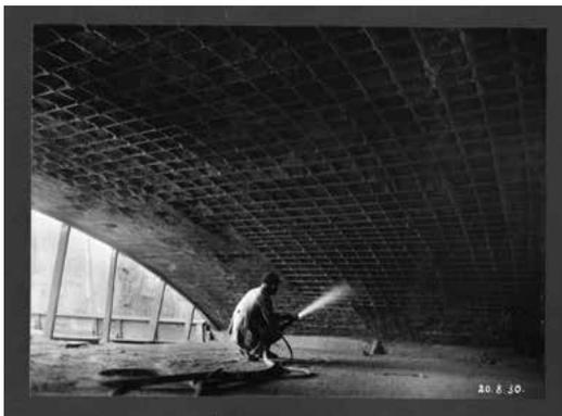
**Bei der Sanierung im Jahr 1930 wird das neue Spritzbeton-Verfahren eingesetzt.**
