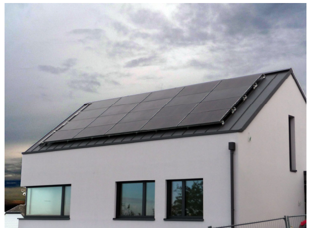
Luxemburg, 20 Kollektoren (Montage auf Blechfalzdach bauseits)
