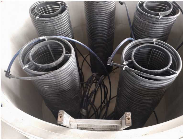
Kreise auf PE-Verteiler geschweißt
