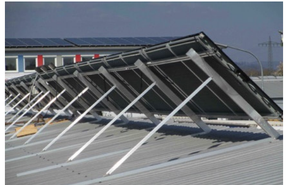
Consolar Gebäude, Lörrach (Vorserie-Montagegestell)
