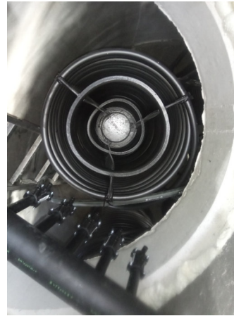
Kreise auf PE-Verteiler geschweißt
