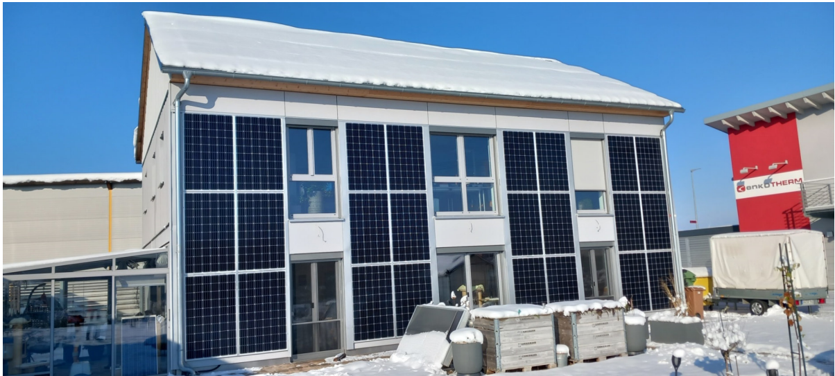
7 kWp „Winter-Strom“ aus der Fassade
