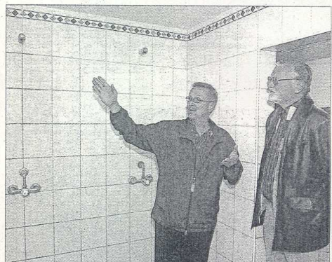
Damit dem Verein auch in den Duschen weniger Energie verloren geht: Matthias Schwing (li.) berät Hans-Jürgen Dauth vom VfL in Langwasser. Foto: Niklas
