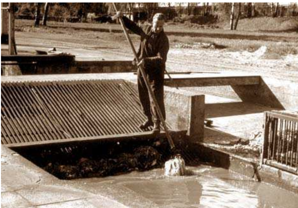
In den 1950er Jahren: Der ursprüngliche Rechen, der von Hand gereinigt werden musste (hier im Bild), wurde Ende der 1950er Jahre durch einen elektrischen Kletterrechen mit automatischer Reinigung ersetzt.
