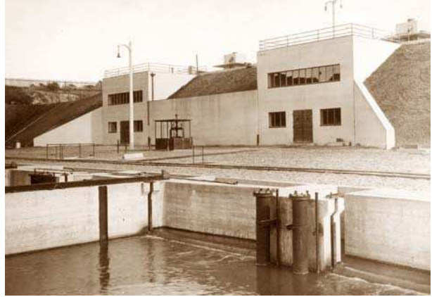
Im Jahr 1931: Die fertige Kläranlage Nord. Hier die Schlamm-faulbehälter.
