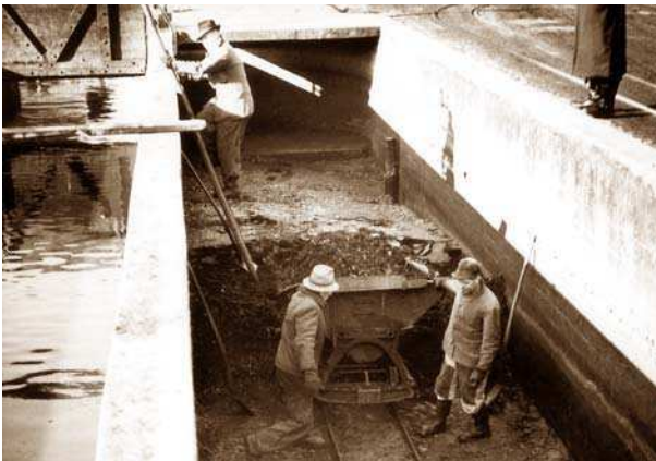
In den 1950er Jahren: Der Sandfang wird geleert. Der abgesetzte Sand wird von Hand in eine Lore geschaufelt.
