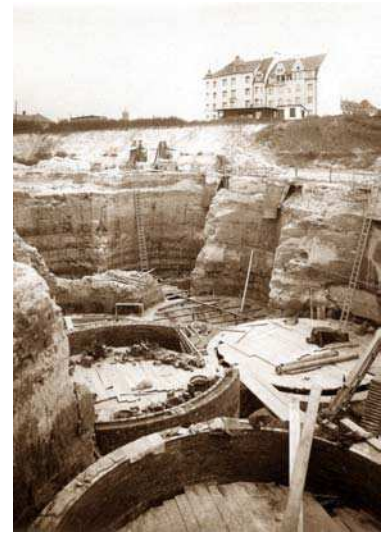
Die Emscherbrunnen der Kläranlage Süd im Bau. Foto von 1912
