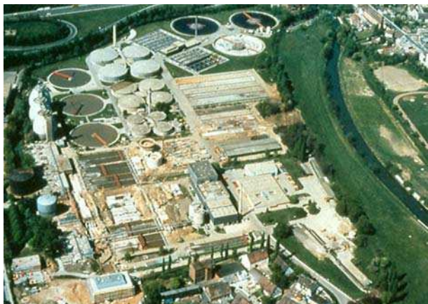
Im Jahr 1983: Die dritte Tropfkörpergruppe ist im Betrieb. Die Vorklärbecken (links unten im Bild) werden erweitert.
