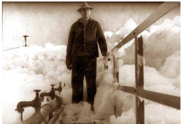
Im Jahr 1955: In der Belebtschlamm-anlage war erstmals eine biologische Reinigung des Abwassers möglich. Dabei sorgten jedoch die Inhaltsstoffe der Waschmittel durch starke Schaumbildung für betriebliche Probleme.
