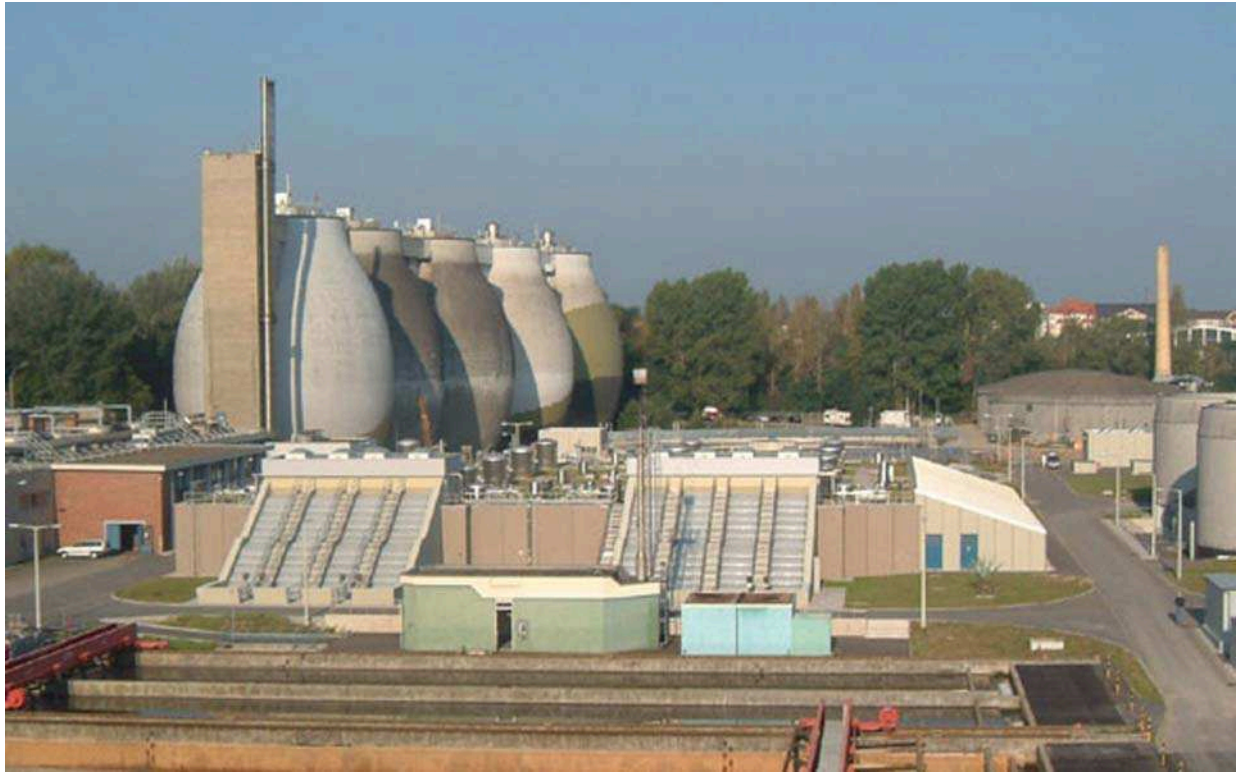
Ein Blick auf die Hochlastbelebungsanlage im Klärwerk 1.
