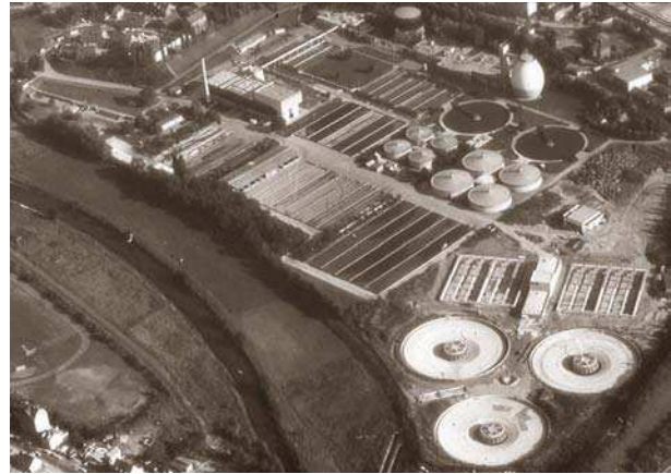
Im Jahr 1973: Die zweite biologische Reinigungsstufe ist im Bau. Die Schlammwässerungsanlage (links oben im Bild) ist in Betrieb.
