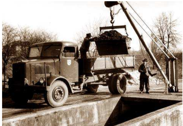
In den 1950er Jahren: Der Sandfang wird geleert. Die gefüllte Lore wird mit einem Kran nach oben gehoben. Der Inhalt wird in einen LKW umgefüllt.
