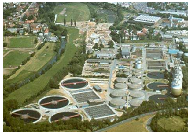
Im Jahr 1990: Die Erweiterung der zweiten biologischen Stufe ist in Betrieb. Alle fünf Fauleier (rechts im Bild) sind vorhanden.
