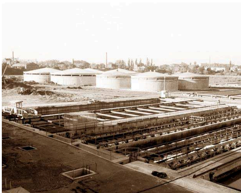
Als früheste biologische Reinigungsstufe nahm im Jahr 1955 die Belebtschlammanlage den Betrieb auf. Ein Jahr später wurde die erste Tropfkörpergruppe fertig gestellt. Auf diesem Foto ist die zweite (linke) Tropfkörpergruppe, die 1963 in Betrieb ging, gerade im Bau.
