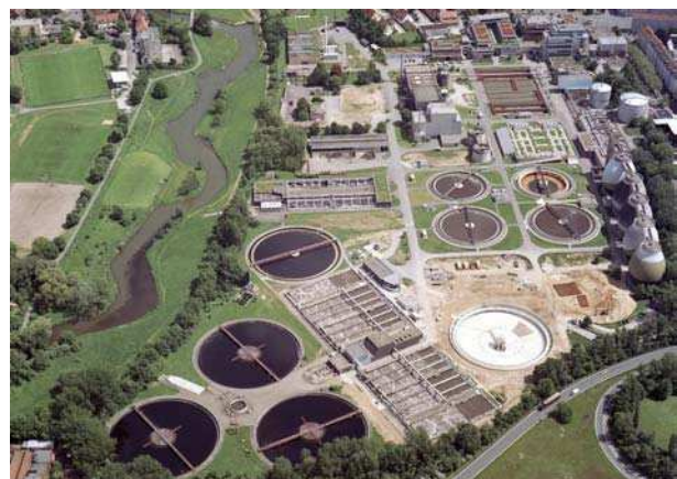
Im Jahr 2005: Die Hochlastbelebungsanlage mit den vier zugehörigen Absetzbecken ist in Betrieb, das fünfte Nachklärbecken ist im Bau.
