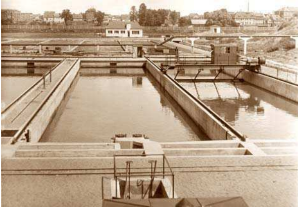
Im Jahr 1931: Die fertige Kläranlage Nord. Hier der Blick auf die Absetzbecken und auf die Schlamm-trockenbeete.
