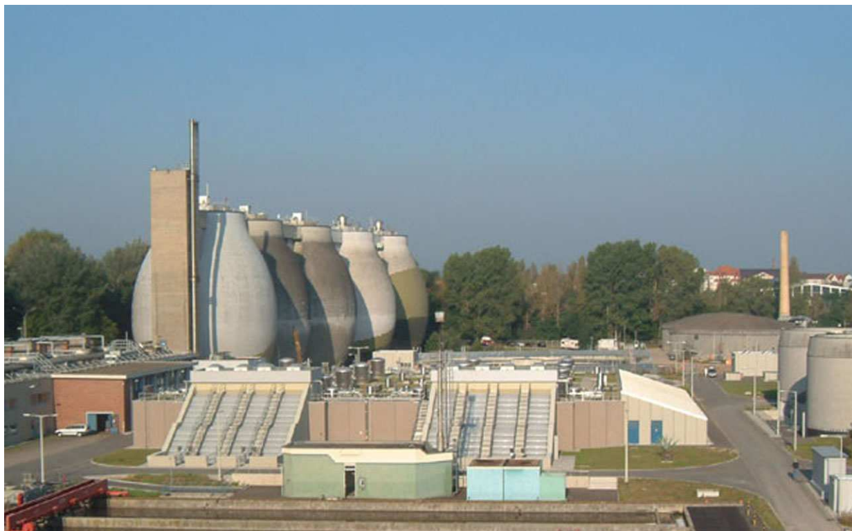
Die Hochlastbelebungsanlage im Klärwerk 1. Ansicht von Osten Im Hintergrund die Schlammfallbehälter des Klärwerks
