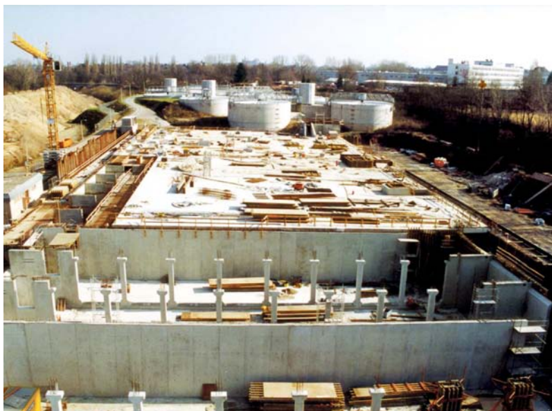
Die Baustelle des Regenüberlaufbeckens im März 1998
