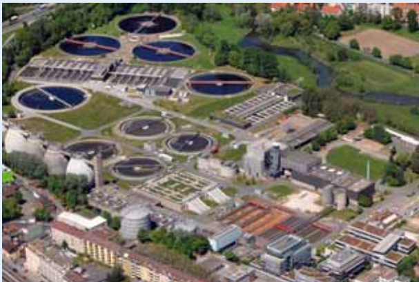
Blick auf das Klärwerk 1 (Foto: Nürnberg Luftbild, Hajo Dietz)
