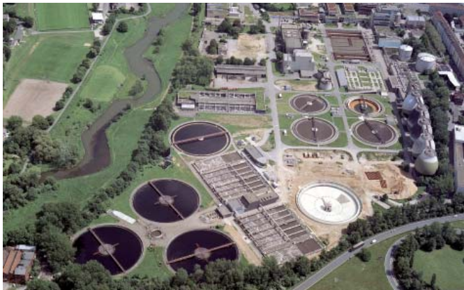
Das Luftbild des Klärwerks 1 zeigt die umfangreichen Ausbaumaßnahmen, die zu einer erheblichen Verbesserung der Gewässergüte in Pegnitz und Regnitz führten.
