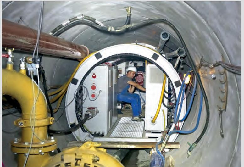
Der Steuerstand der Vortriebsmaschine unmittelbar hinter der Spitze des Rohrstrangs – der Ortsbrust.\*
