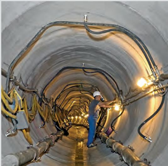
Der zukünftige Hauptsammelkanal von innen. Die beiden Rohre an der Kanalsohle dienen zum Abtransport des Bodens und zur Zuführung der Stützflüssigkeit.\*
