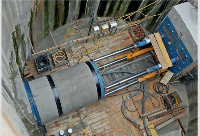
Die Betonrohre werden vom Startschacht aus in den Boden gepresst. Silber glänzend die Zylinder der hydraulischen Pressen. Am rechten Bildrand das Widerlager für die Pressen. Foto: SUN.
