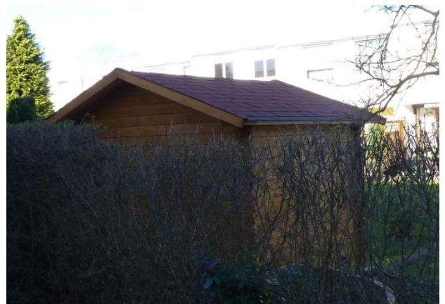
So etwas ist nicht denkmalgerecht
