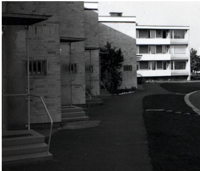
Eingangsbereiche zur Erbauungszeit
