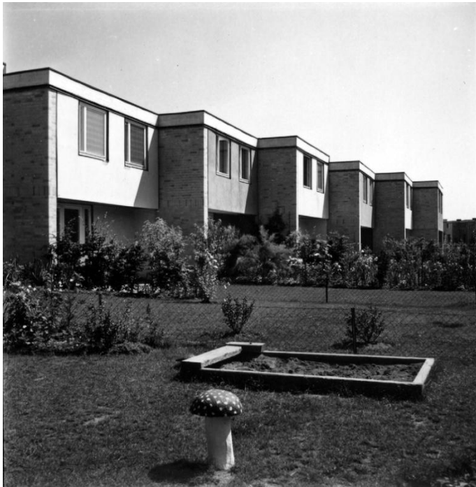
...wie auch bauzeitliches Foto belegt.
