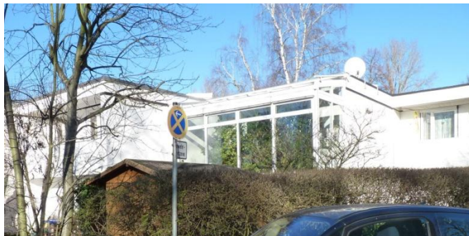
So ein Anbau ist nicht denkmalgerecht
