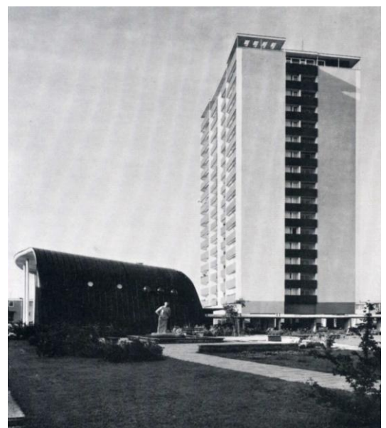
Wasch- / Heizhaus und 16-geschossiges Hochhaus
