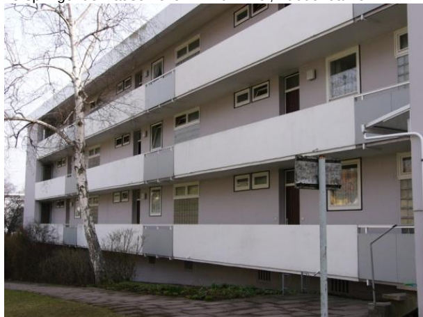
Horizontale Bänderung im 3-geschossigen Mehrfamilienhaus
