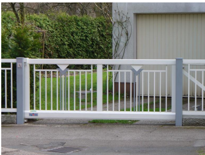
So etwas ist nicht denkmalgerecht
