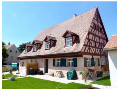
(74) Sichtfachwerk und geschlammte Fassade
