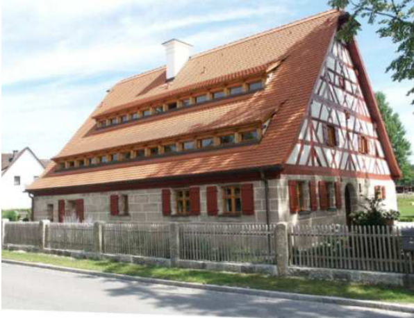
Beispiele: (42) Doppelreihige Bandgauben
