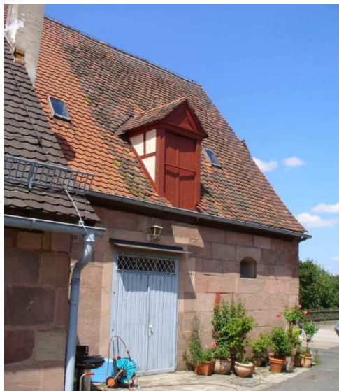
(102) Stallfassaden vor dem Umbau
