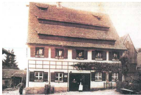
(38) historisches Bauernhaus mit Lüftungsgauben
