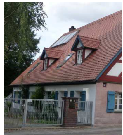
(89) Solarthermie im hinteren Bereich
