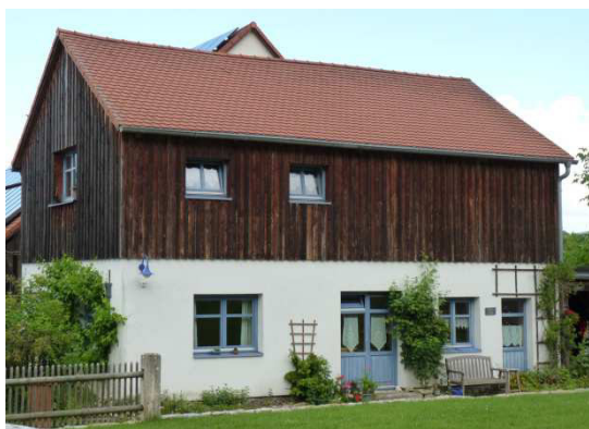
(79) Nebengebäude mit verputztem Sockelgeschoss
