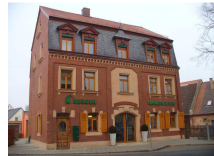
(75) Sichtziegelmauerwerk (alte Schmiede)
