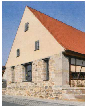
(71) neue Öffnungen am Giebel
