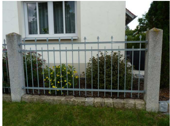
(82) neu gestalteter Eisenzaun
