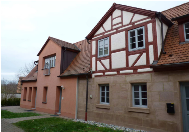
(48) Zwerchhäuser verputzt, in Fachwerk....
