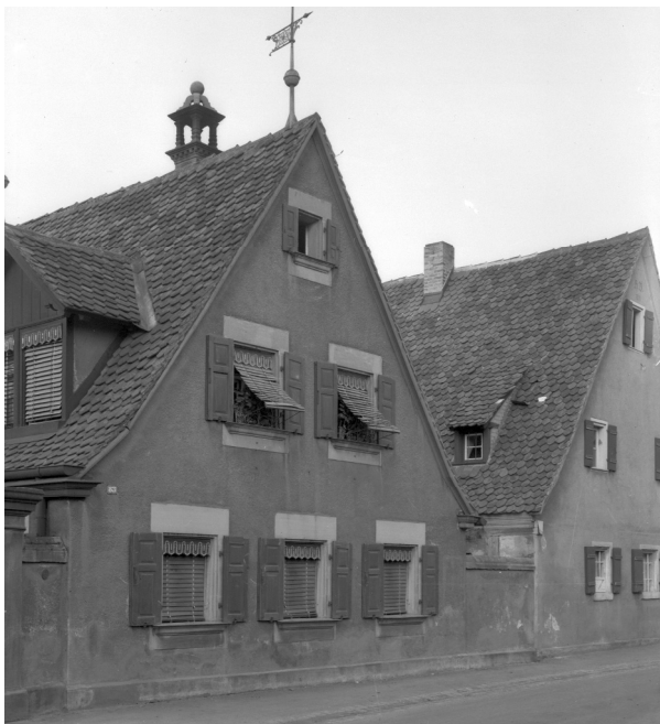
(24) Nr. 83 und 85 vor der Zerstörung
