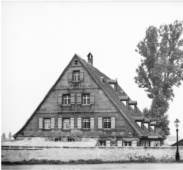
(22) Nr. 77 vor der Zerstörung
