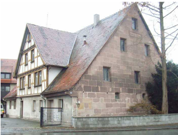
Beispiele: (44-45) Zwerchhäuser zur Belichtung von Wohnraumerweiterungen im Dach
