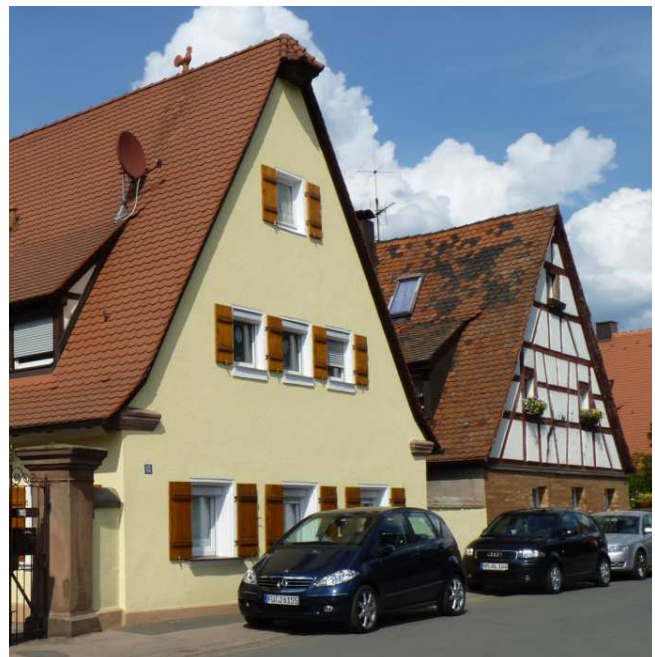
(25) Nr. 83 und 85 Wiederaufbau
