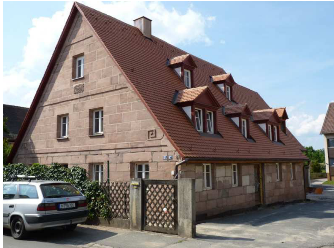
(13) Giebel mit eckiger Fassadenzier
