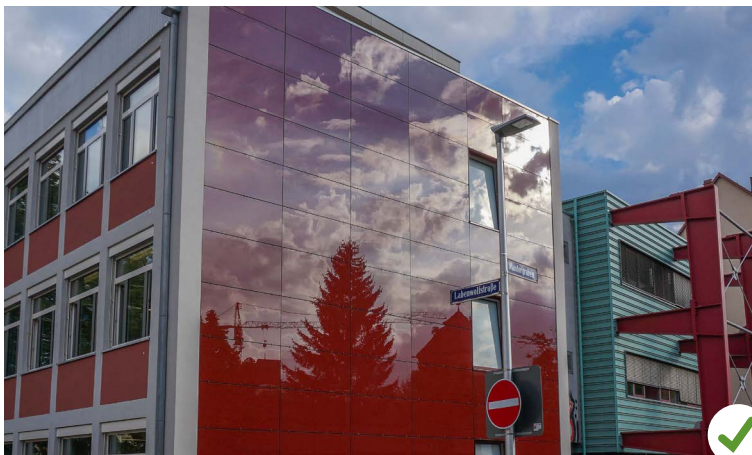
Farbige Fassadenphotovoltaikanlage am Anbau des denkmalgeschützten Labenwolf-Gymnasium, unmittelbar gegenüber der historischen Stadtmauer
