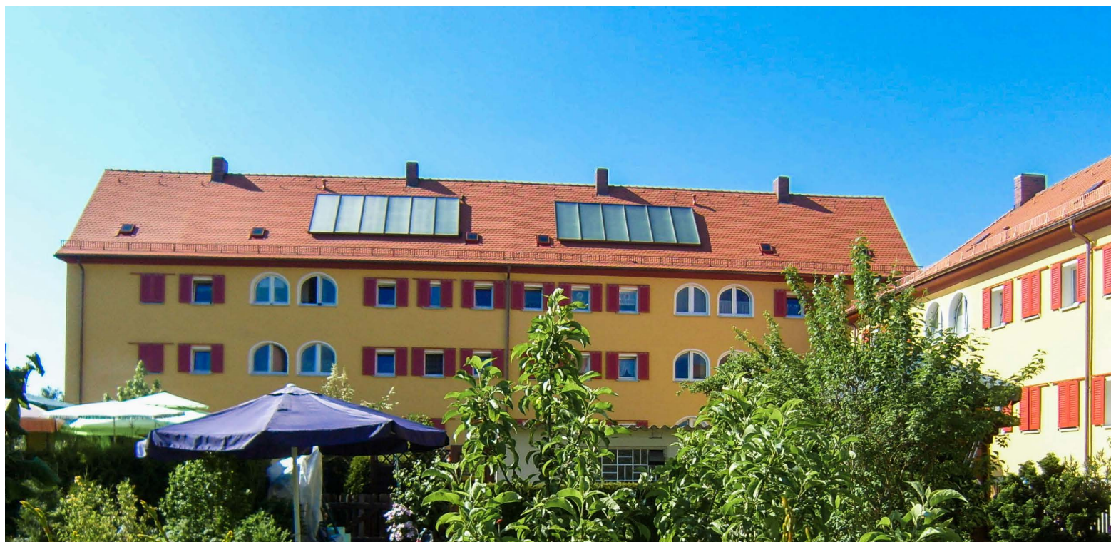
Ensemble Gartenstadt – Julius-Loßmann-Straße: Solarthermieranlage zum Innenhof hin
