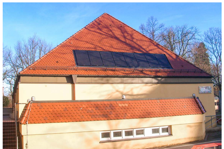
Sperberschule Hortgebäude (Denkmalnähe): dachintegrierte PV-Anlage in schwarz
