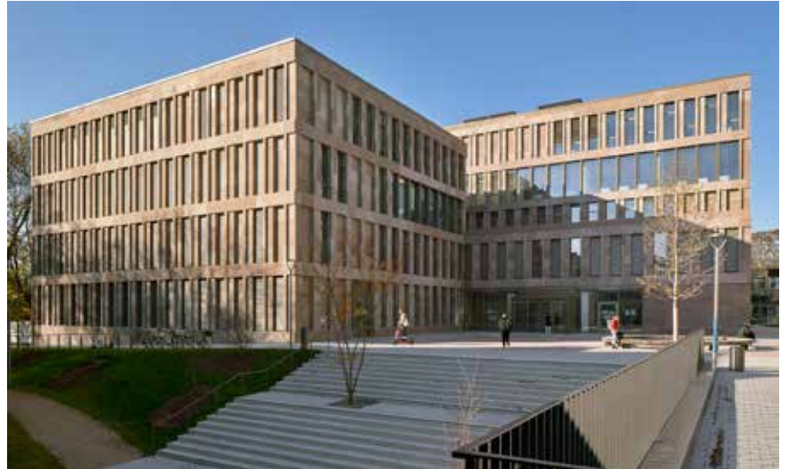
Rechenzentrum vorne, Bibliothek hinten
