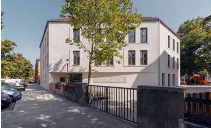
Straßenansicht Bauernfeindstraße Foto: Felix Meyer
