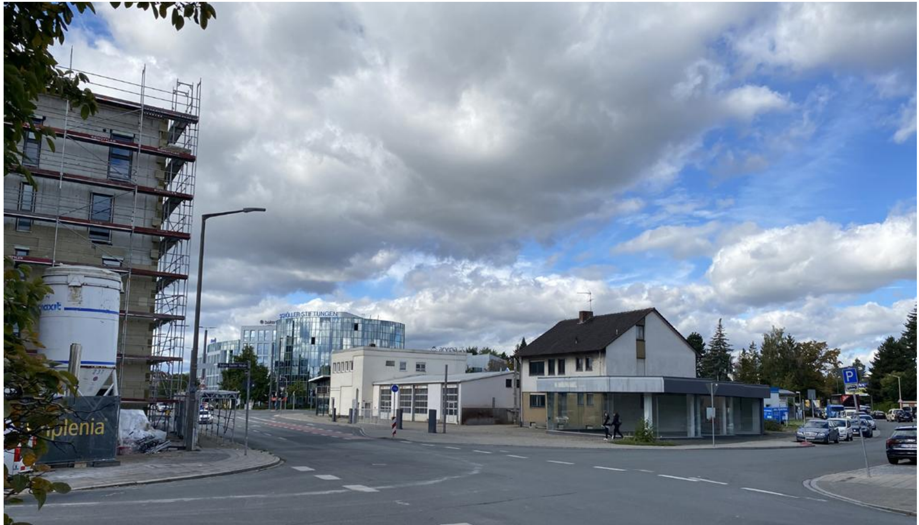
Blick nach Nord-West auf das Grundstück
