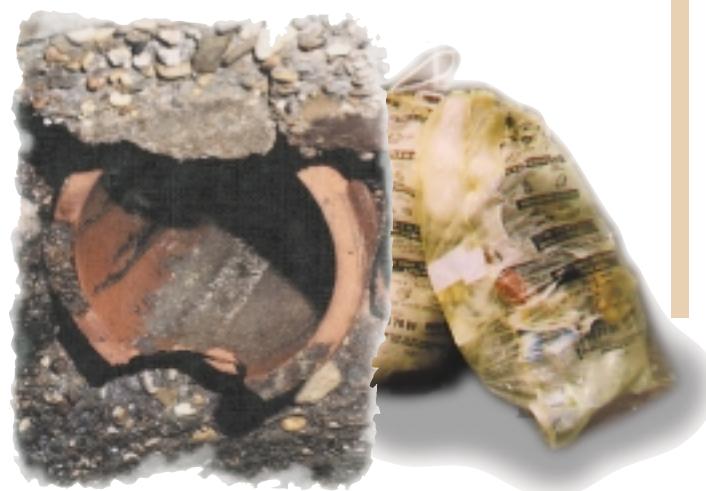
Stein, Niederehe, Instandhaltung von Kanalisationen
