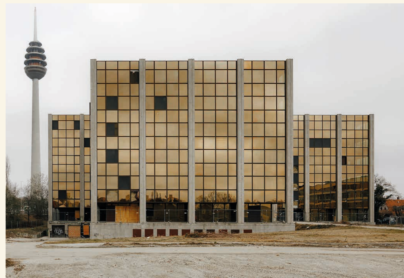
Neues Schulzentrum B5 und B14, © Giulia Iannicelli
