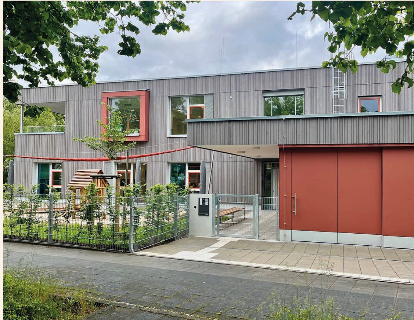
Neubau, Haus für Kinder
