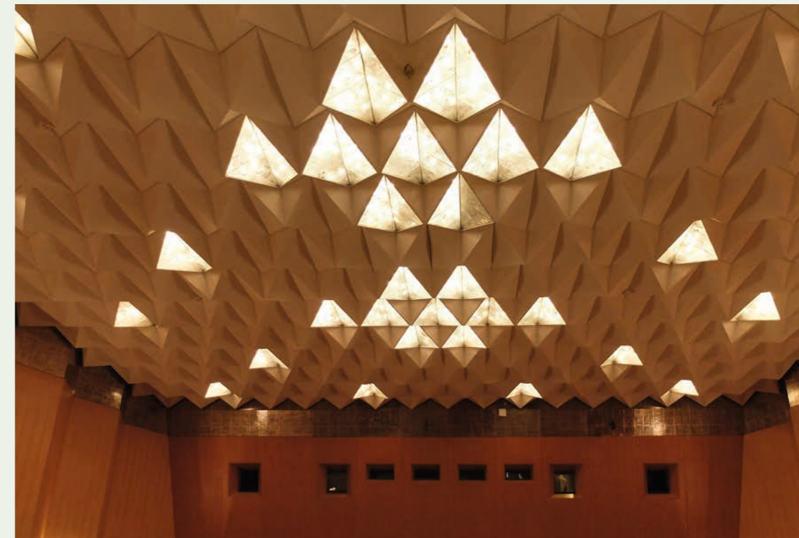
Erneuerung der Beleuchtung im kleinen Saal
