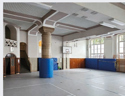
Bismarckstraße 18–20, Erneuerung Turnhallenboden
