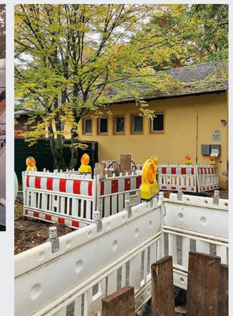
Regensburger Straße 412, Erneuerung Wasserleitungen
