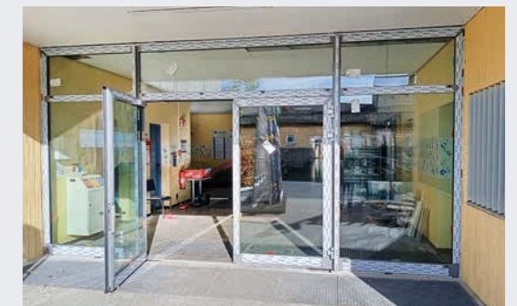
Billrothstraße 16, Erneuerung Eingangstüren
