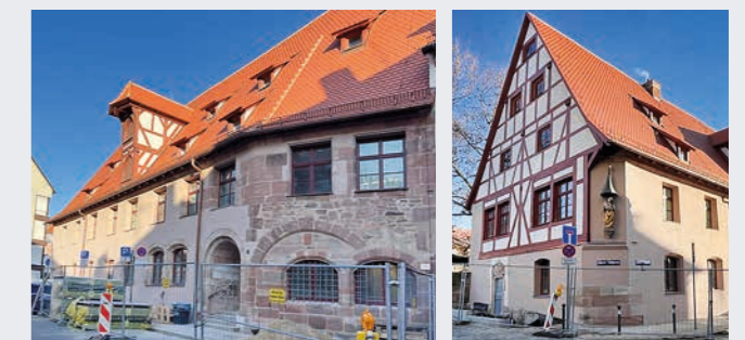
Untere Talgasse 8, Umbau Hort und Kinderhaus © Gumbrecht Architekten BDA GmbH
