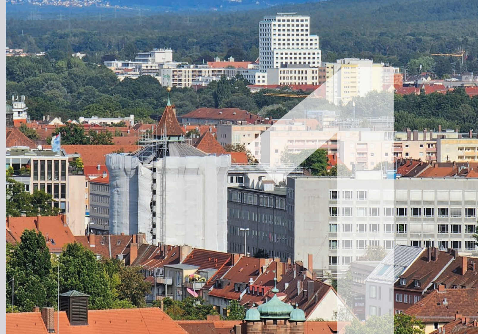
Laufertorzwinger 1, Laufertorturm, Fassaden- und Dachsanierung
