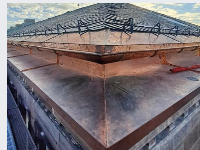
Adam-Kraft-Straße 2, Sanierung Schule
