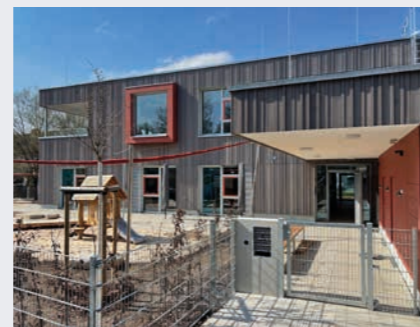
Luther-King-Straße 11, Haus für Kinder, Neubau
