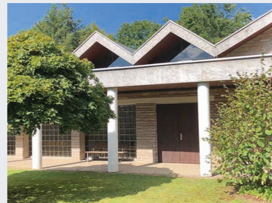
Boxbergweg 27, Sanierung Flachdach und Versickerungsanlage
