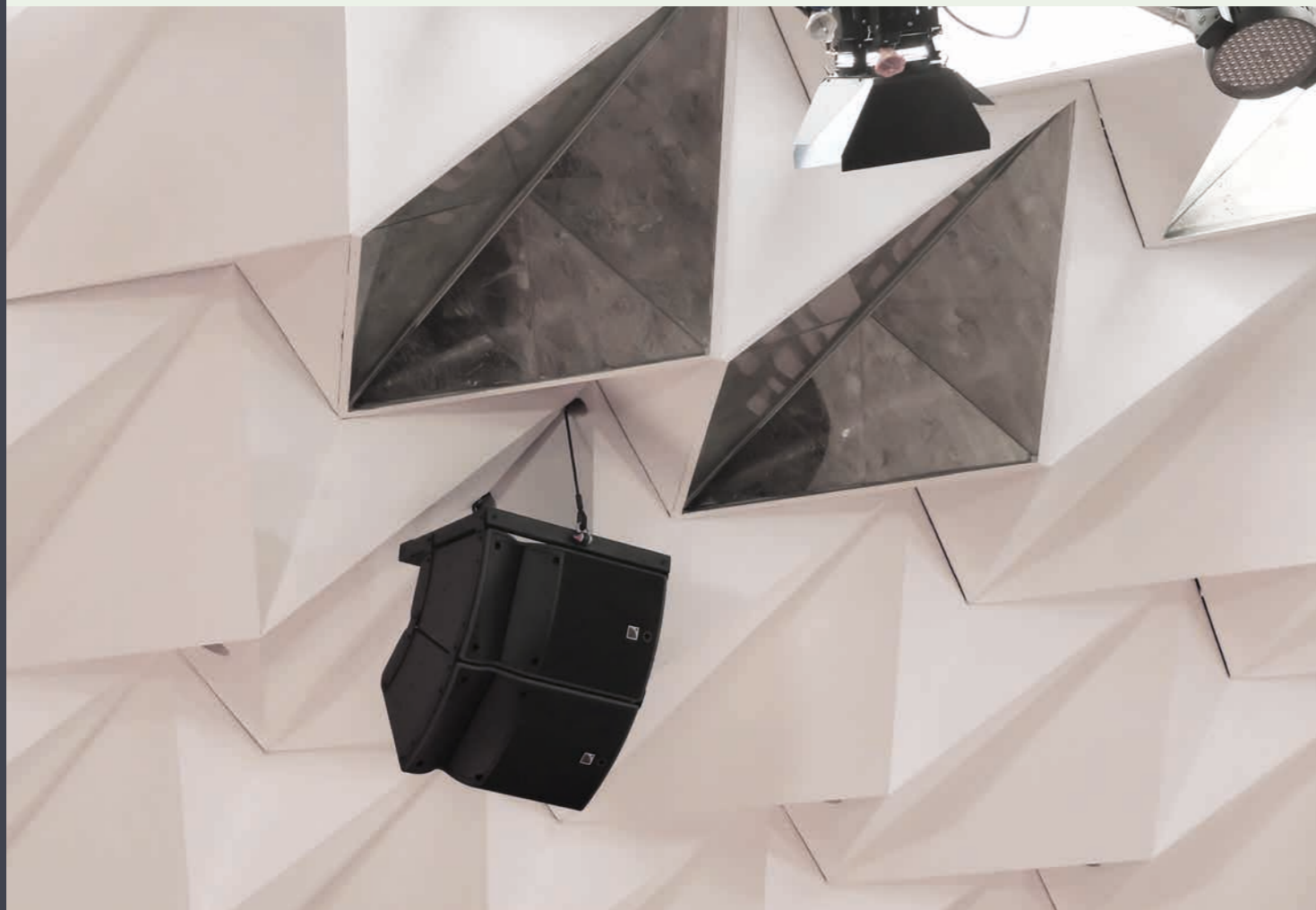
Erneuerung der Beschallungsanlage
