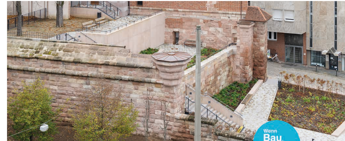
Marientormauer 15, Sanierung nördlicher Marientorzwinger © Uwe Niklas
