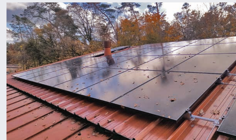
Am Tiergarten 30, Betriebshof, Einrichtung Photovoltaikanlage
