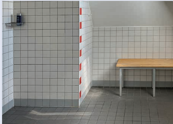
Duschanierung Feuerwache 2, vor Sanierung
