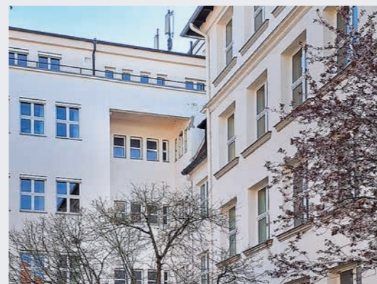
Rollnerstraße 15, Generalsanierung des Bestandsgebäudes
