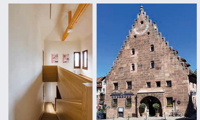
Mariantormauer 15, Sanierung nördlicher Marientorzwinger © Uwe Niklas Unschlittplatz 7a, Verwaltungsgebäude, Sanierung Fassade
