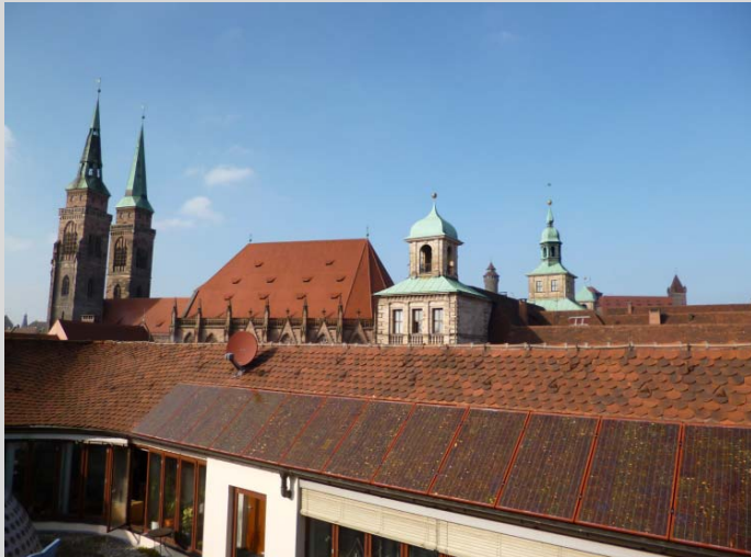
Bild 1: PV-Anlage auf dem Neuen Rathaus, Hauptmarkt 18
