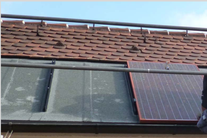
Bild 4: Indach-Unterkonstruktion
