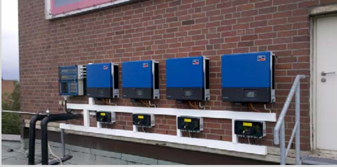
Bild 4: Wechselrichter am süd.stadt.bad
