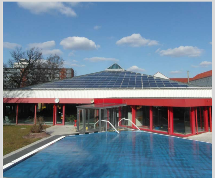
Bild 6: PV-Anlage auf dem Nordostbad mit 99,8 kWp
