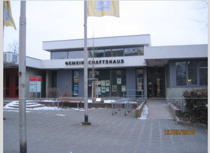
Abb. 9: Gemeinschaftshaus Langwasser – vor Sanierung
