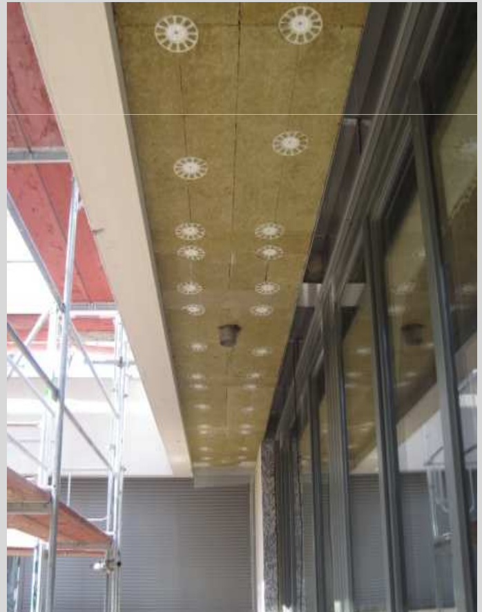
Abb. 5: Foto Ausführungsdetail (Zustand nach Sanierung)
