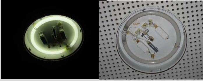
Bild 3: Leuchte vor der Sanierung
