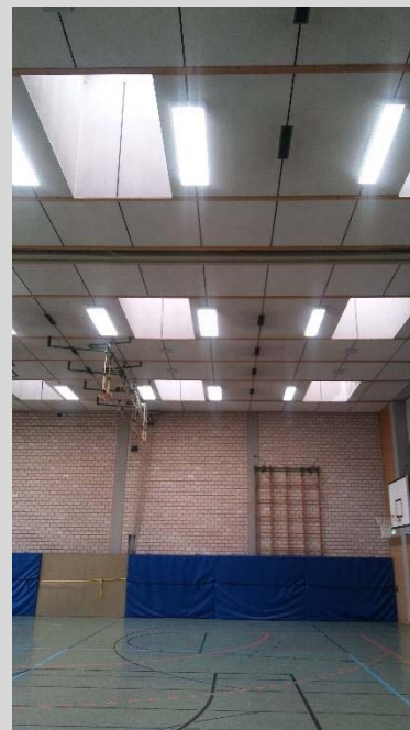
Bild 3: Halle nach der Sanierung
