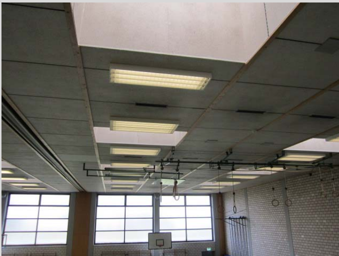
Bild 2: Halle vor der Sanierung
