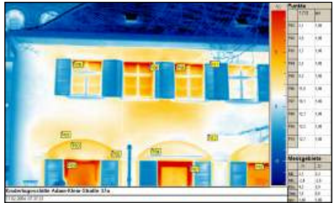
Bild 2: Wärmebild der Ostfassade vor Sanierung
