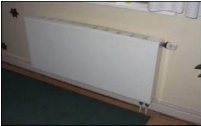
Bild 3: Plattenheizkörper mit einstellbarem Ventileinsatz
