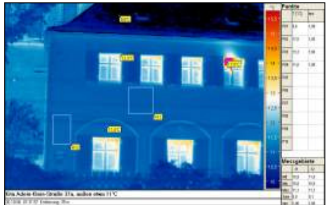
Bild 5: Wärmebild der Ostfassade nach Sanierung
