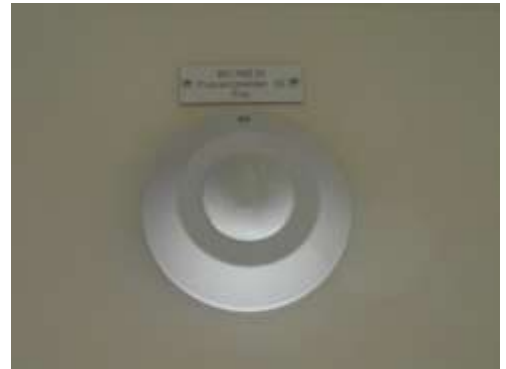
Bild 5+6: Flur mit neuer Beleuchtung und Präsenzmelder
