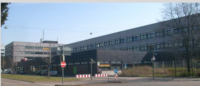
Bild 2: BBZ Nürnberg (Ansicht von Osten)
