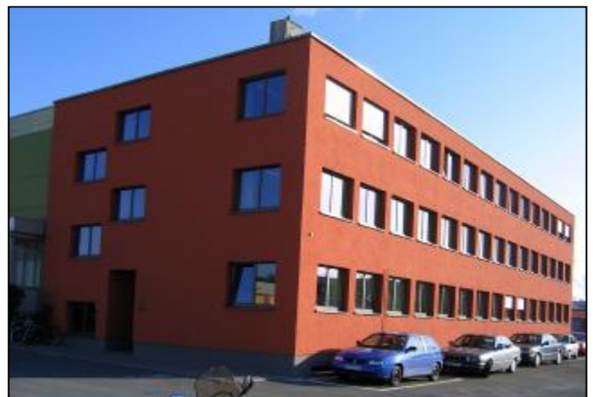
Bild 13: Süd-Fassade Verwaltungsgebäude Donaustraße nach der Sanierung
