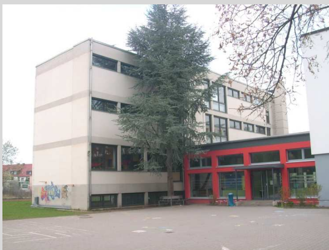
Bild 2: Grundschule Fischbach (Südansicht)
