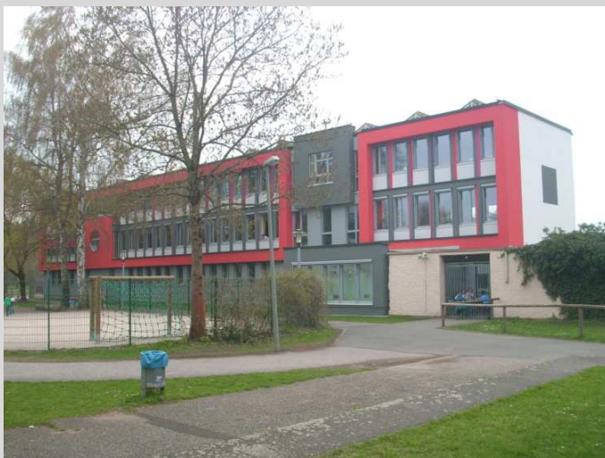
Bild 1: Grundschule Fischbach (Westansicht)
