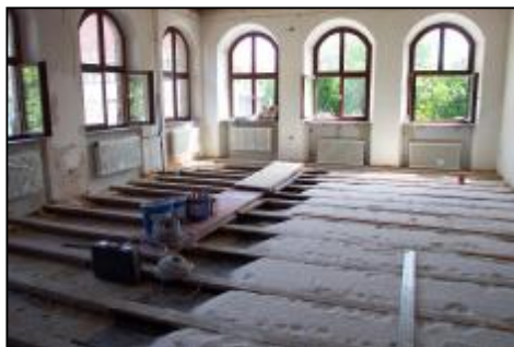
Bild 11: Fußboden- und Innendämmung Herrenschießhaus
