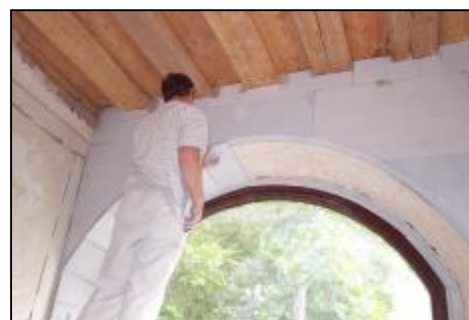
Bild 10: Innendämmung der Fensterleibungen
