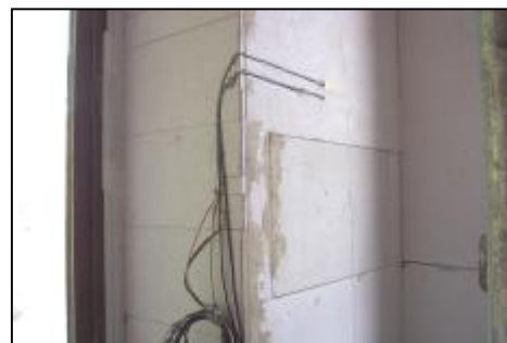
Bild 2: Einbau der Messfühler vor dem Kleben der Innendämmung
