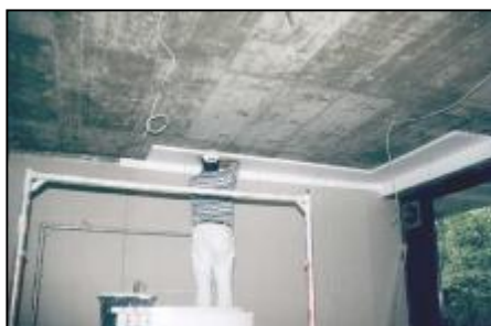
Bild 6: Innen-dämmung der Wärmebrückenbereiche
