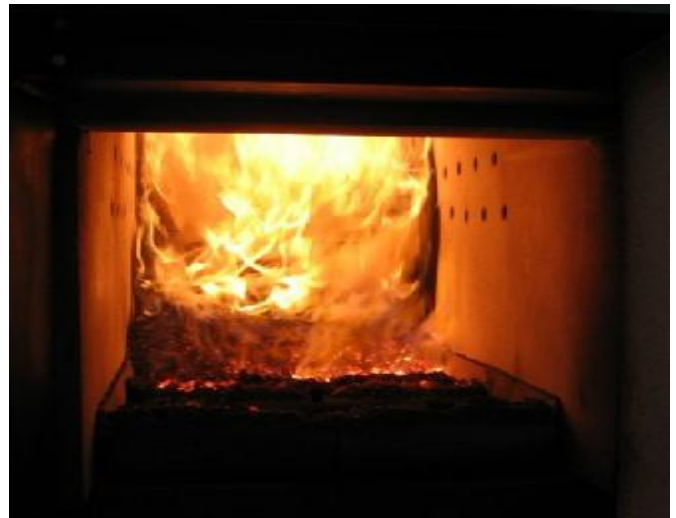
Bild 3: Brennkammer mit Vorschubrost.
