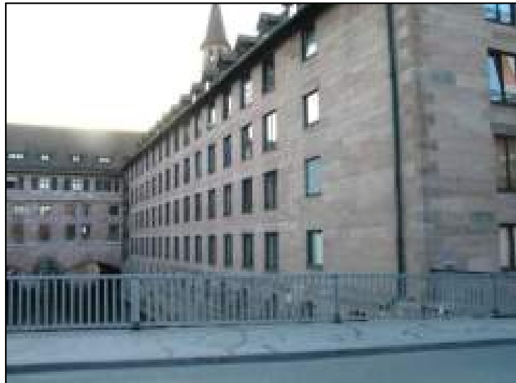
Bild 10: Heilig-Geist-Haus Südfassade, Hans-Sachs-Platz 1
