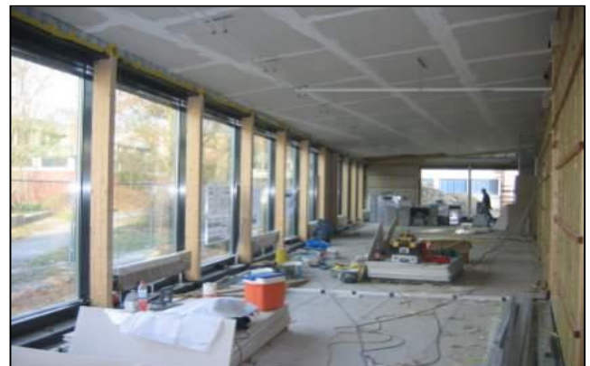
Bild 5: Baustelle Ganztagesbetreuung Neues Gymnasium Nürnberg im März 2008 (Quelle: Hochbauamt Nürnberg)
