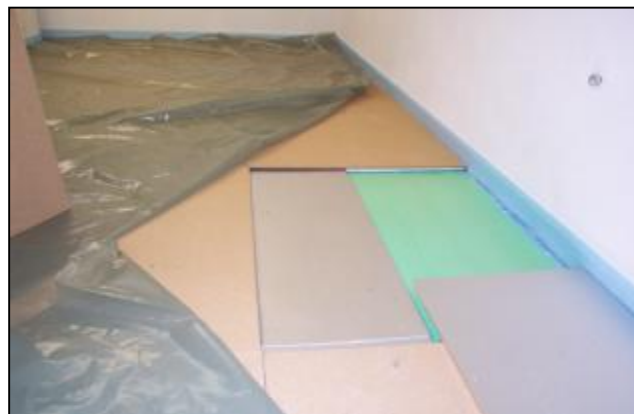
Bild 11: Fußbodenaufbau im Keller Maxfeldstraße
