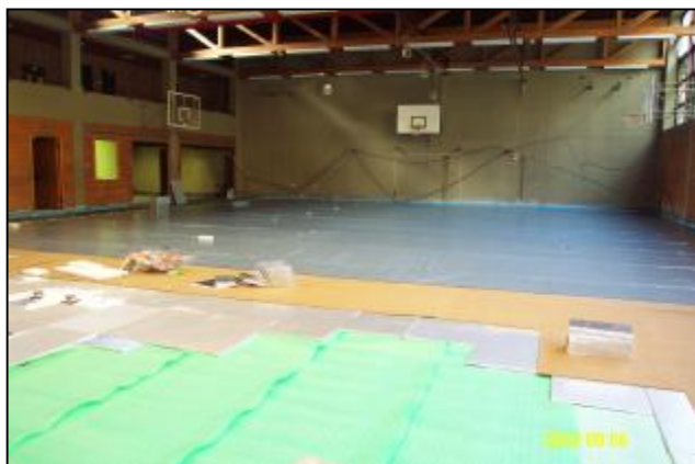
Bild 12: Turnhalle Jean-Paul-Platz während der Sanierung
