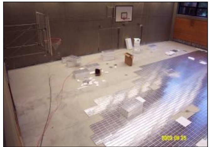
Bild 5: Turnhalle während der Sanierung
