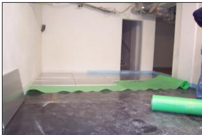
Bild 10: Kellerboden Maxfeldstraße während des Einbaus der VIP-Platten
