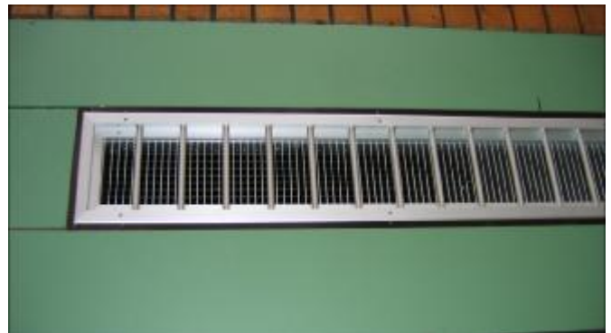
Bild 6: Neu: Selbsttätig verstellendes Zuluftgitter, ballwurfsicher
