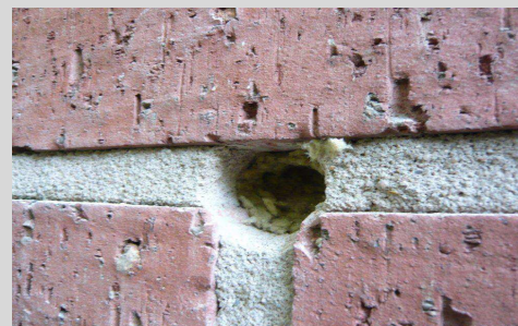
Bild 5: Einblasöffnung für Wärmedämmung
