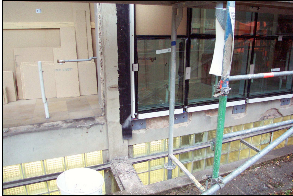
Bild 9: Detail der Fassade während der Sanierung
