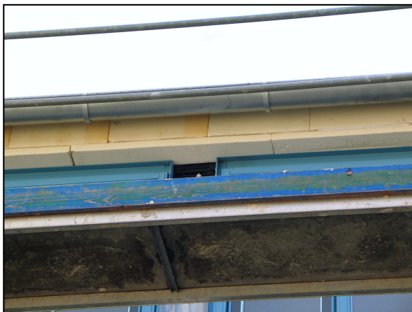
Bild 10: Sturz mit Wärme- dämmung
