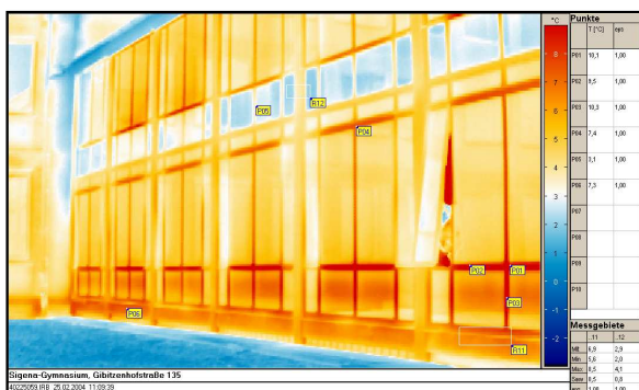
Bild 13: Wärme- bild der Fassade vor der Sanierung
