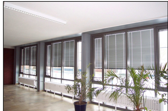
Bild 11: Innen- ansicht nach der Sanierung
