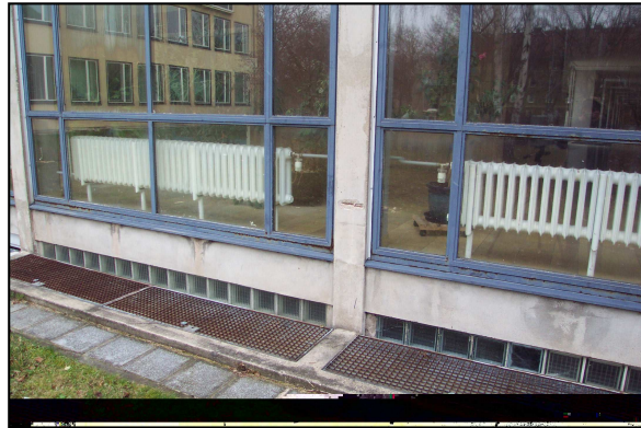
Bild 5: Detail der Fassade vor der Sanierung
