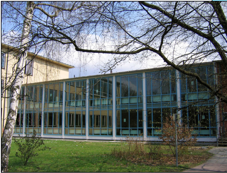
Bild 1: Westfassade des Verbindungsbaus Sigena-Gymnasium nach der Sanierung
