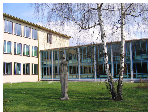
Bild 17: Fassade nach der Sanierung
