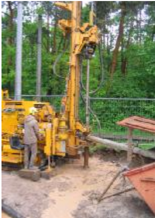
Bild 3: Bohrung für Sonden
