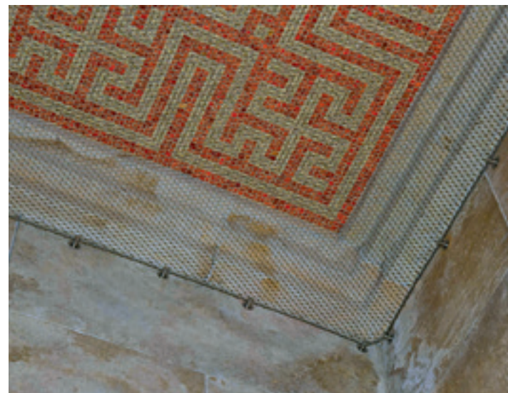
Sicherung von Deckenmosaiken mit einem Stahlnetz.
