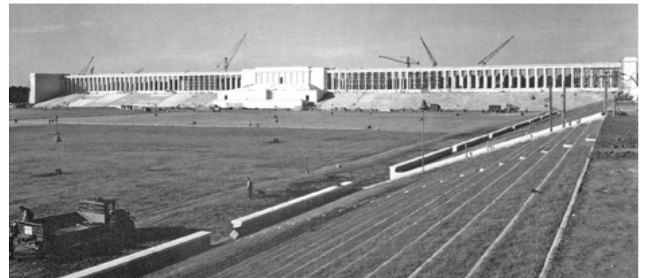
Zeppelintribüne vor dem Reichsparteitag 1936. Bis dahin sind der Rohbau und die Außenfassaden weitgehend fertiggestellt.
