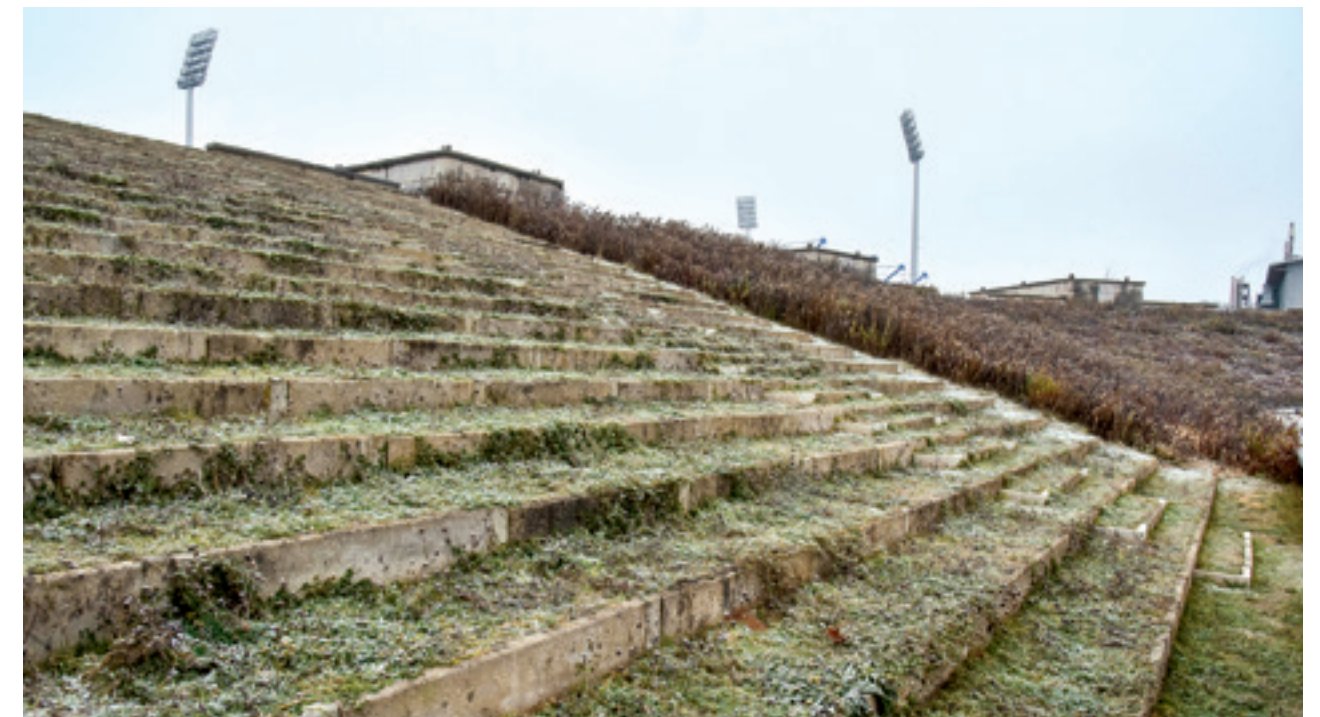
Zustand an einer ausgewählten Fläche der Wallanlage nach dem Austausch der obersten Erdschicht.
