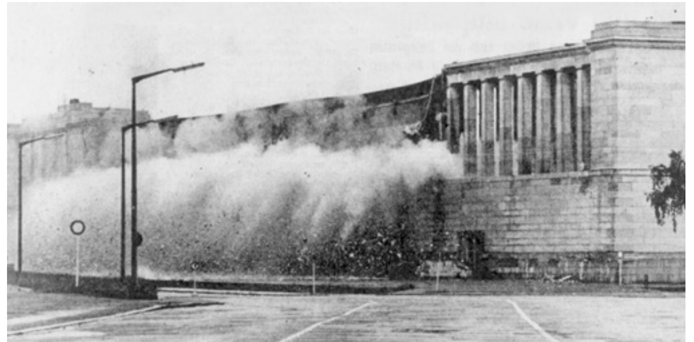
Sprengung der Pfeilerreihen auf der Haupttribüne, 1967.
