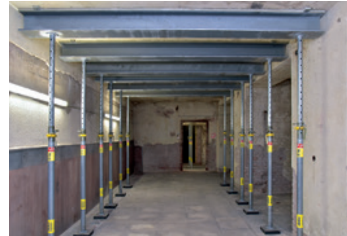
Sicherung im Inneren der Zeppelintribüne mit Stahlstützen.
