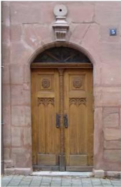
Links: Sanierter Eingangstür Rechts: Sanierter Fassade
