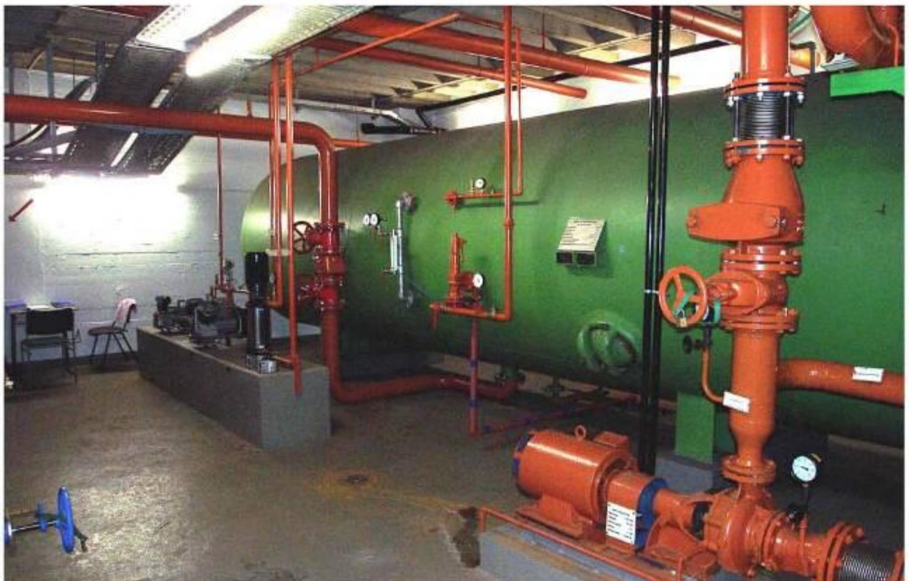
Oben: Außenlift mit verglastem Schacht Unten: Sprinklerzentrale mit Vorratstank
