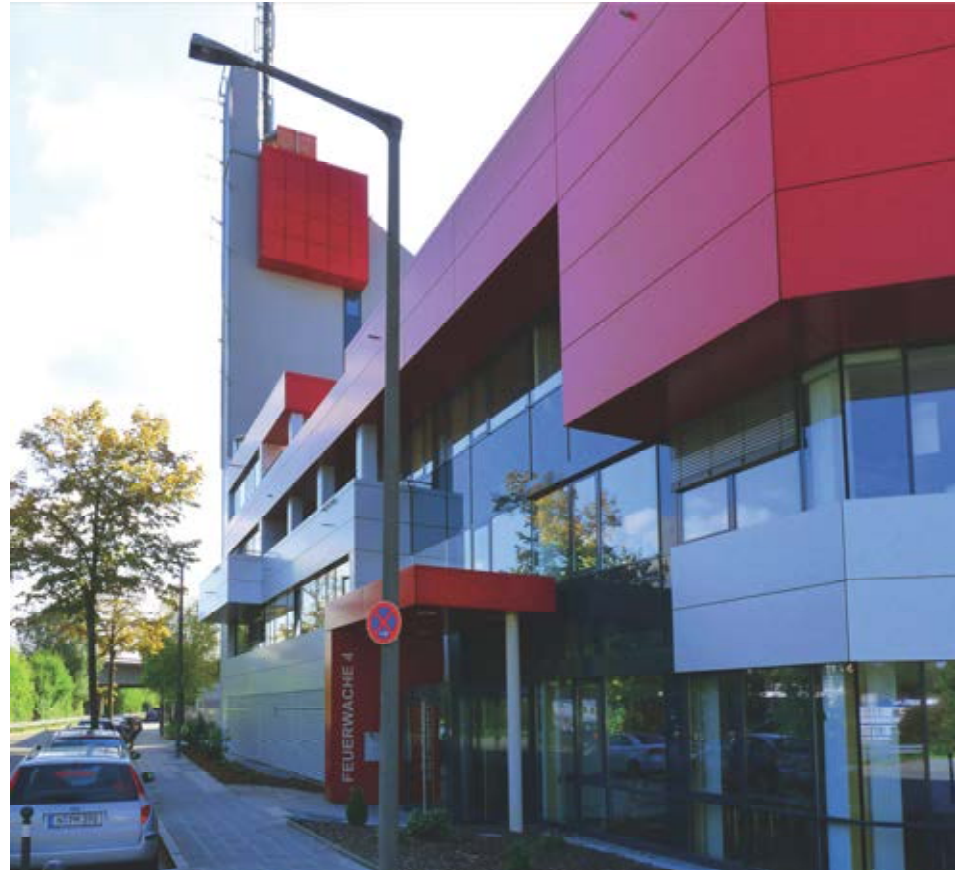
Links Oben: Fahrzeughalle
