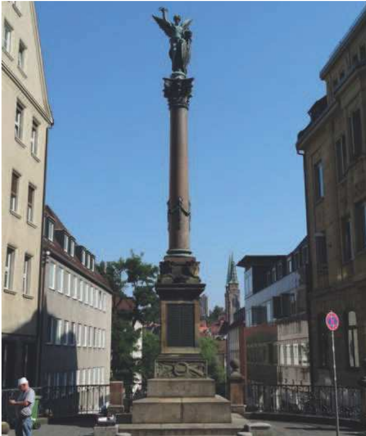
Links: Ansicht der Säule vor der Sanierung
