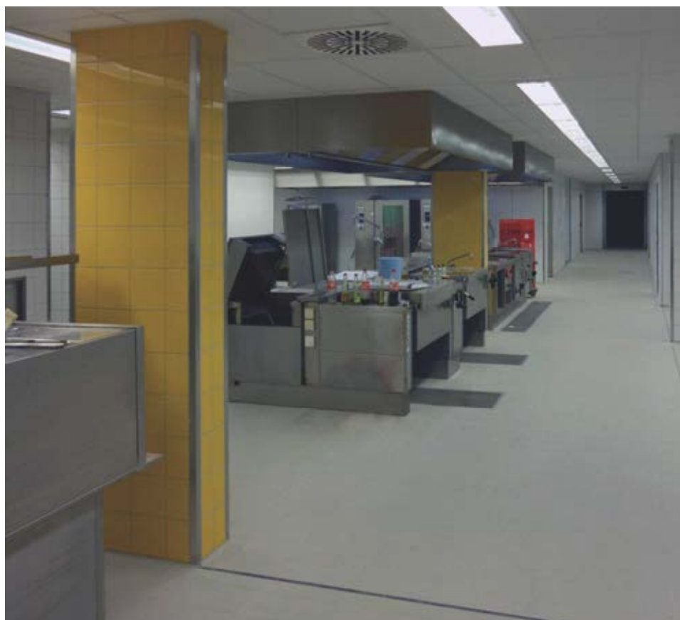
Oben: Küche nach der Sanierung
