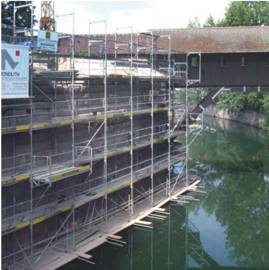
Oben: Nordseite zur Pegnitz während der Natursteinsanierung
