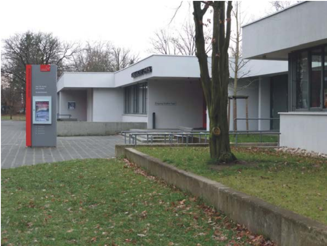
Oben: Ansicht Westen Nebeneingang
