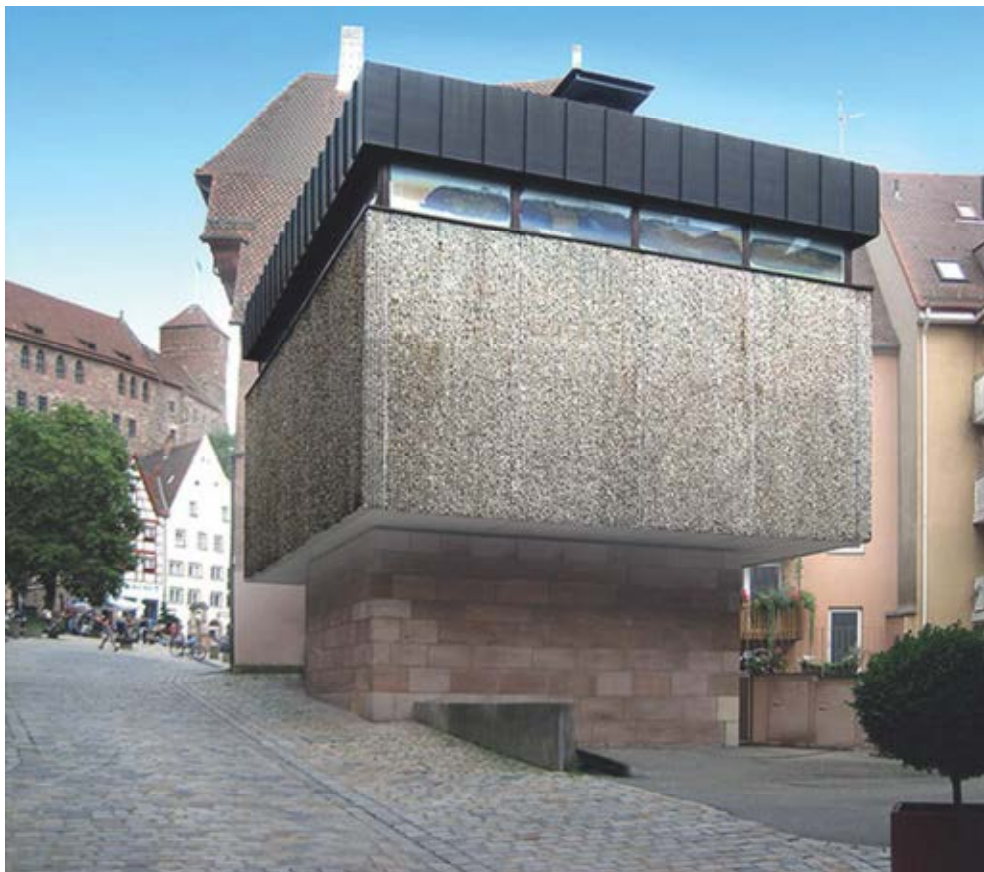
Oben: Anbau Dürerhaus vor Umbau
