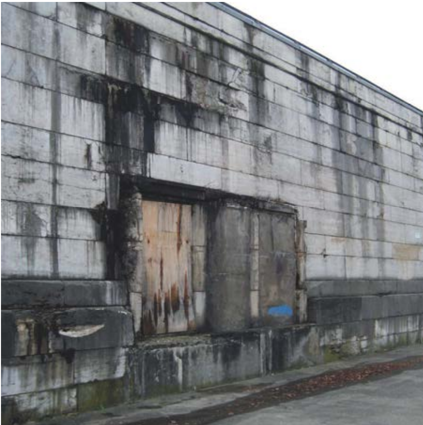
Oben: Rückseite Tribüne, ehemalige Zugänge
